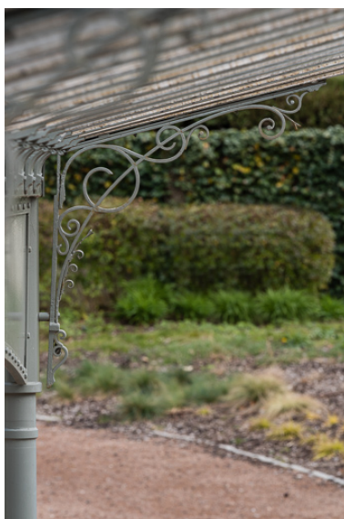
Buvette "reconstruite" à son emplacement actuel, détail de la structure d'origine. Phot. Pierre-Marie Barbe-Richaud IVR26_20195800259NUC4A
