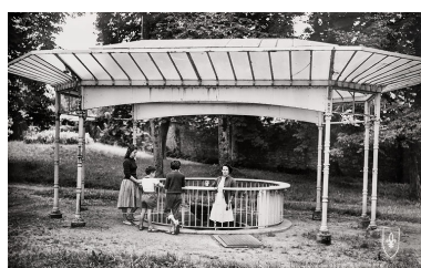
Buvette sur le site du Ponteau, premier état d'abandon (années 1970). Phot. Pierre-Marie Barbe-Richaud, Autr. auteur inconnu IVR26_20205800344NUC4A
