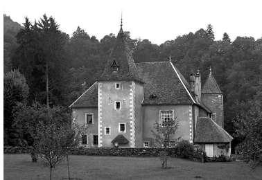
Demeure située rue du Sur Saulle à Scey-en-Varais. Phot. Yves Sancey IVR43_19802501146X
