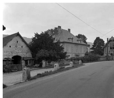
Demeure située Grande Rue à Maisières-Notre-Dame. Phot. Yves Sancey IVR43_19802501166X
