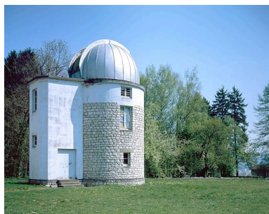
Vue d'ensemble, depuis l'ouest. Phot. Jérôme Mongreville IVR43_20022501245VA
