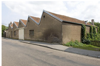
Vue de trois quart droite. Phot. Jérôme Mongreville IVR43_20077000417NUCA
