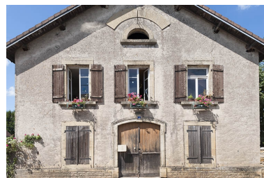
Façade antérieure. Phot. Jérôme Mongreville IVR43_20127000423NUC4A
