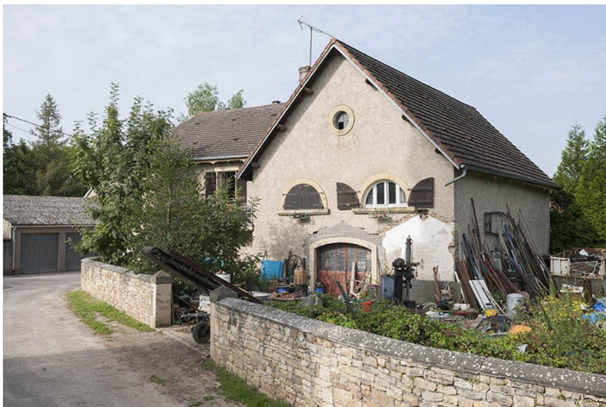
Façades latérale droite et postérieure.
