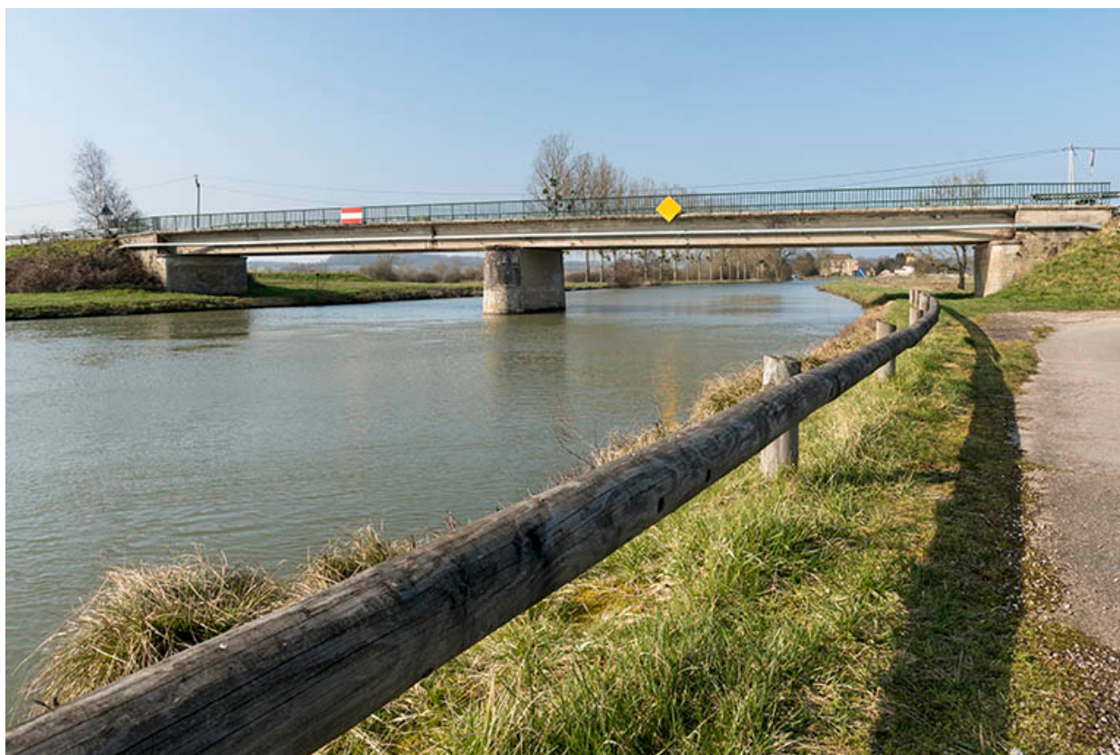
Pont routier franchissant la rivière.
