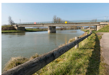
Pont routier franchissant la rivière. Phot. Sonia Dourlot IVR43_20167000287NUC4A
