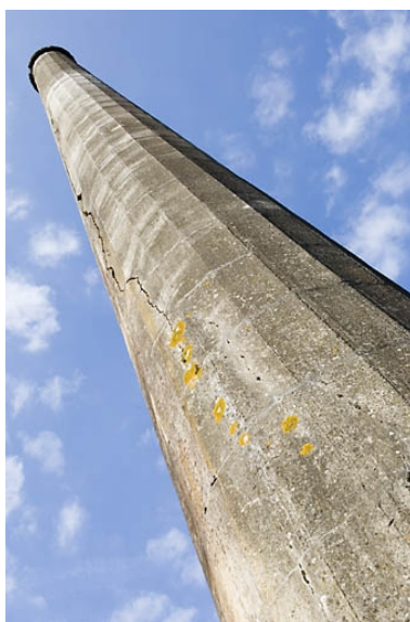
Cheminée vue en contre-plongée (2). Phot. Jérôme Mongreville IVR43_20087000944NUC2A
