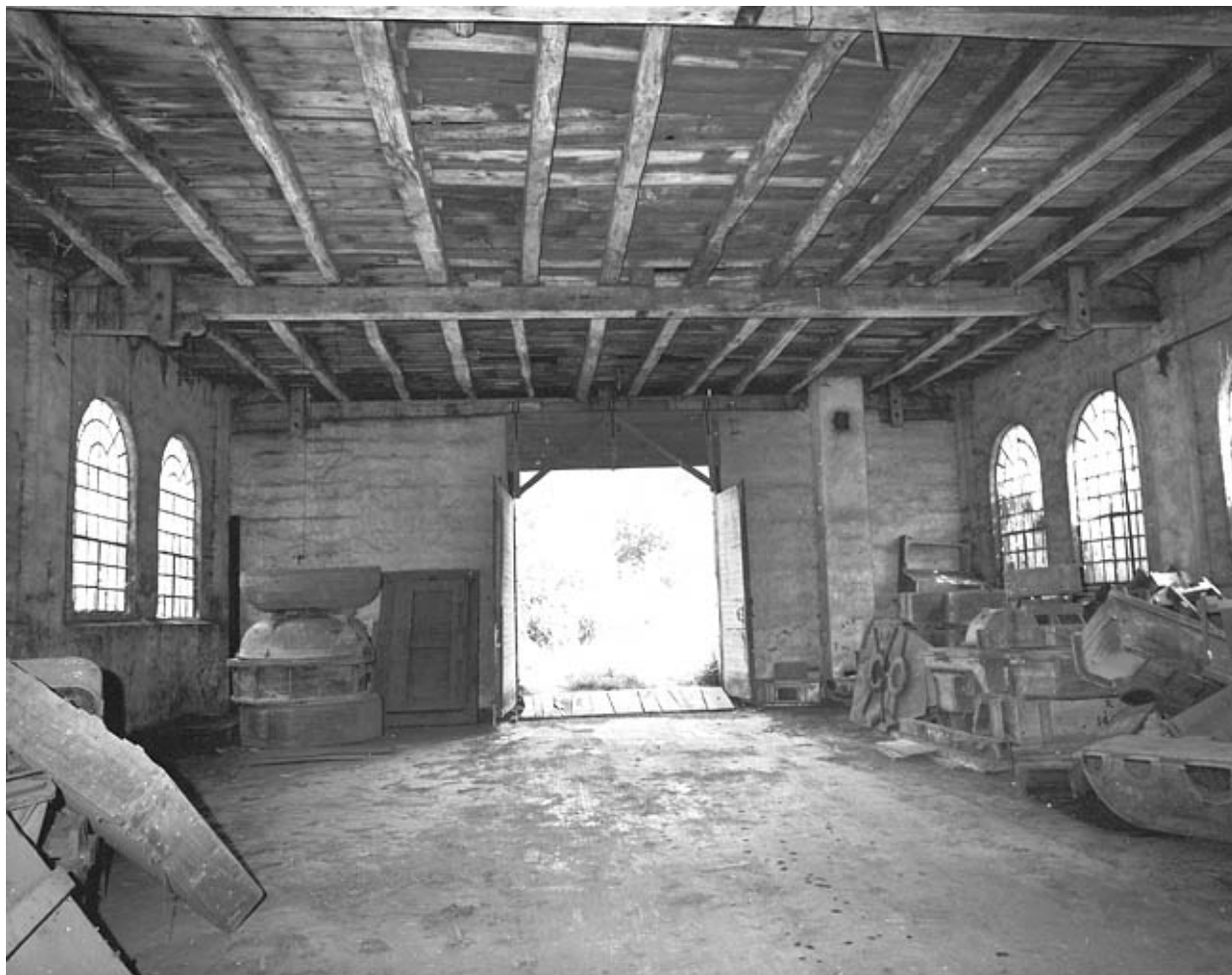
Partie sud de l'atelier de fabrication en 1981.
