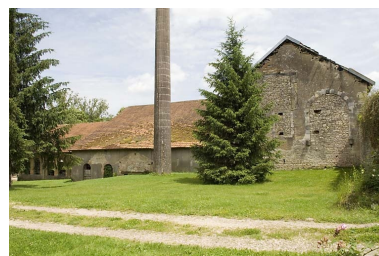
Atelier de fonderie et mur- pignon du haut fourneau. Phot. Jérôme Mongreville IVR43_20087000949NUC2A
