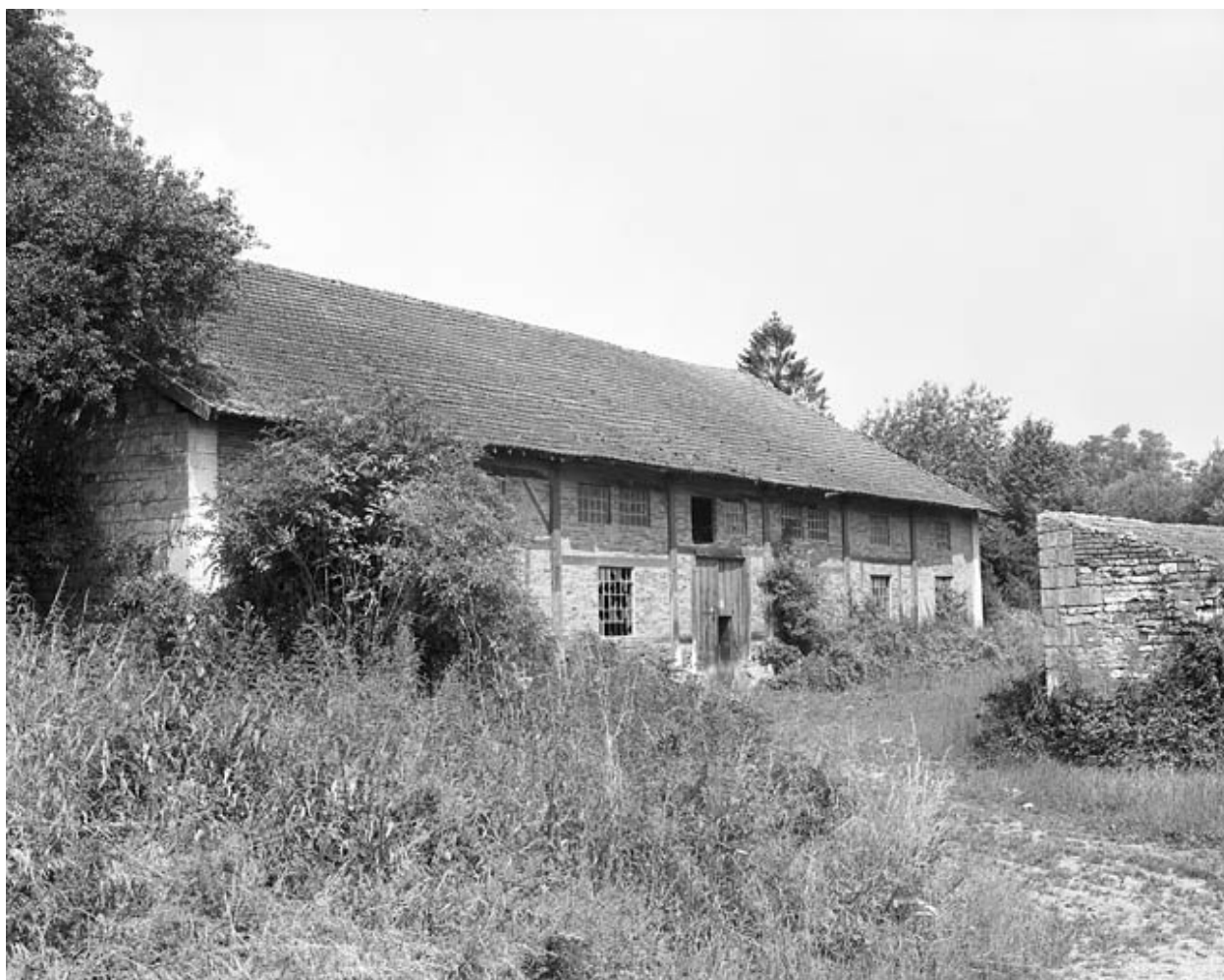
La halle à charbon en 1981.
