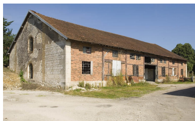
Magasin industriel vu de trois quarts. Phot. Jérôme Mongreville IVR43_20087000939NUC2A
