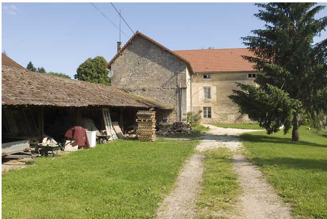
Appentis et logement patronal depuis l'entrée.
