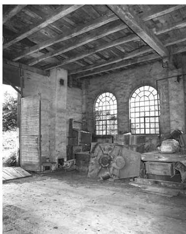
Angle nord de l'atelier de fabrication en 1981. Phot. Jérôme Mongreville IVR43_20097000102X
