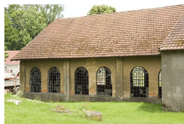
Façade ouest de l'atelier de fonderie. Phot. Jérôme Mongreville IVR43_20087000948NUC2A
