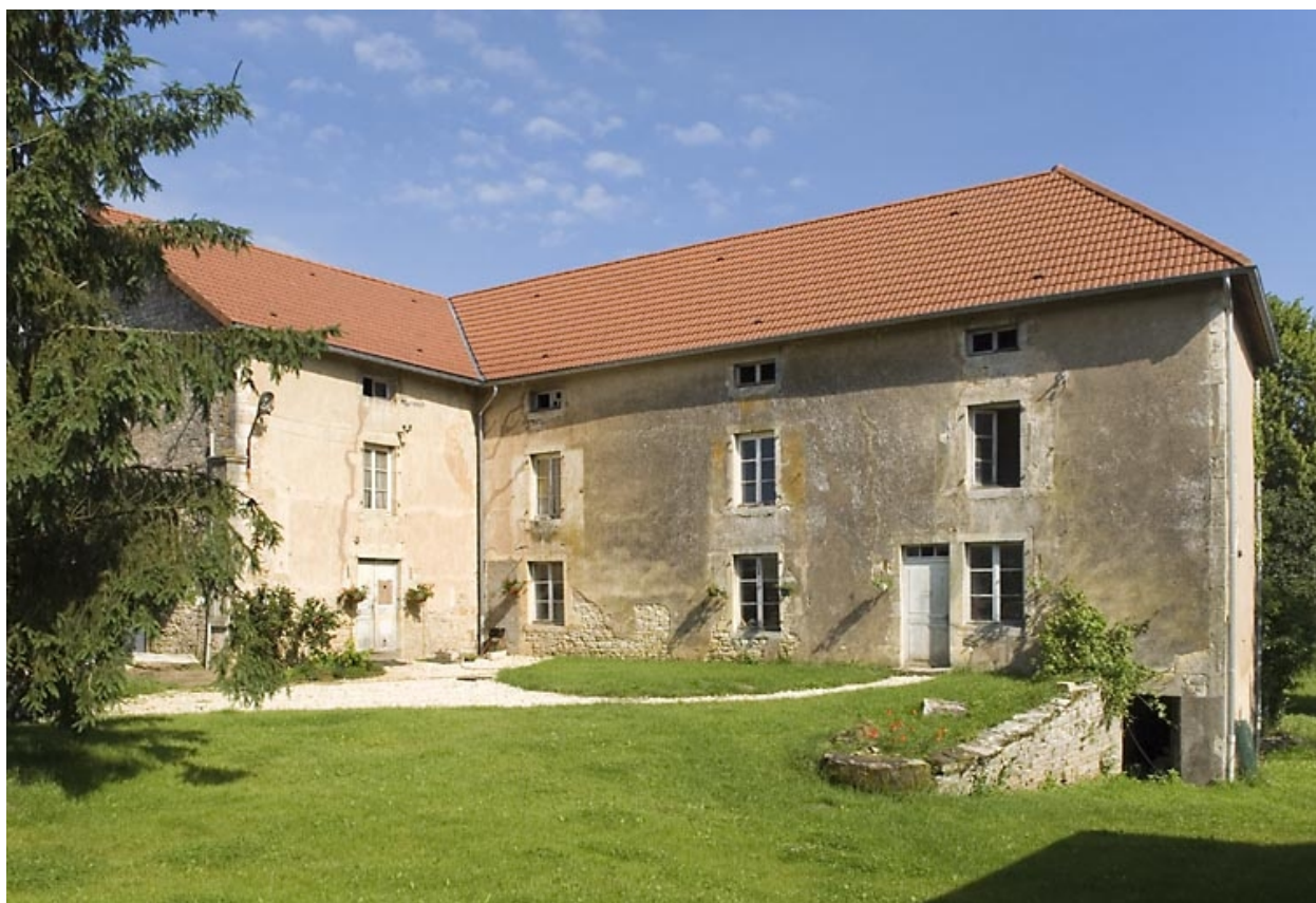
Logement patronal vu de trois quarts.
