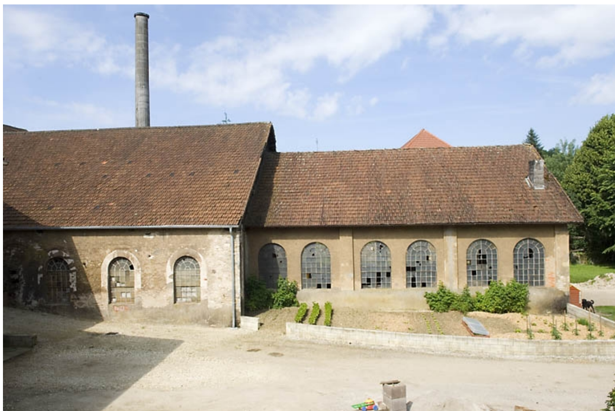
Façade est de l'atelier de fonderie.
