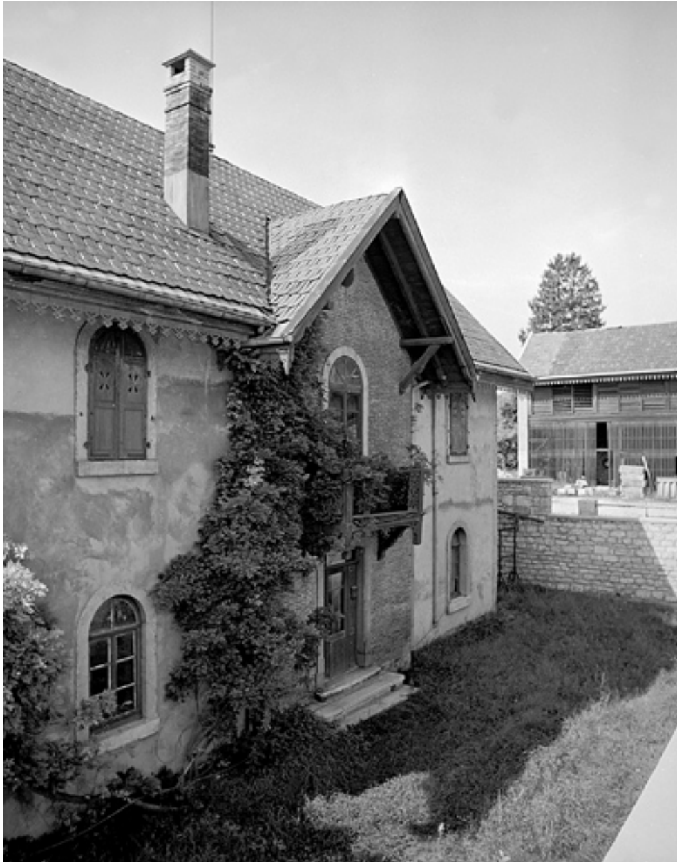
Façade est de la conciergerie en 1981.SRI. Enquête régionale sur les bâtiments industriels (1979-1981).
