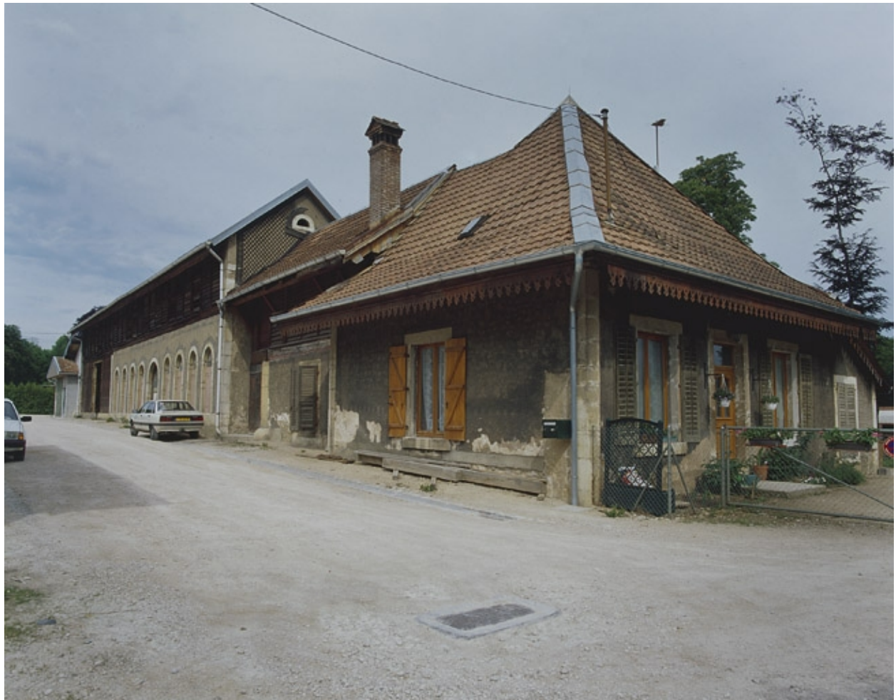
Orangerie et logement depuis l'est.
