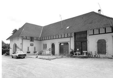
Bâtiment à usage agricole (étable, fenil).
