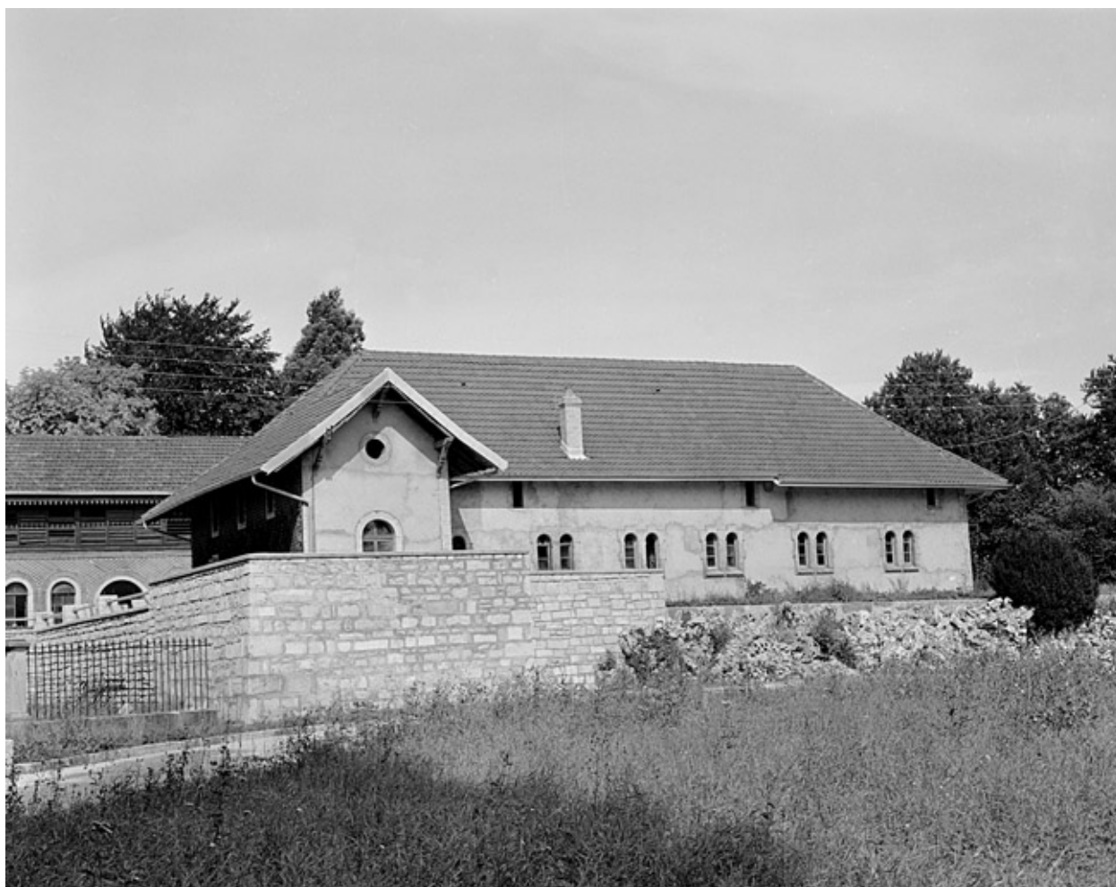
Façade sud des écuries en 1981.SRI. Enquête régionale sur les bâtiments industriels (1979-1981).
