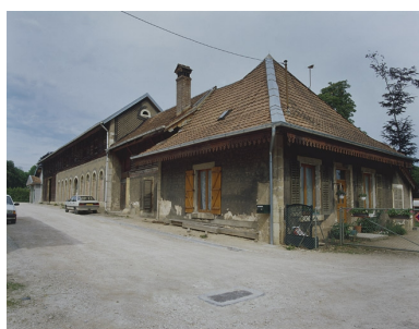
Orangerie et logement depuis l'est.
