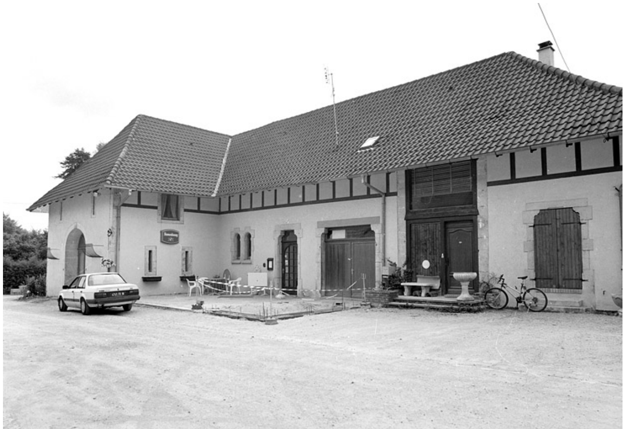
Bâtiment à usage agricole (étable, fenil).
