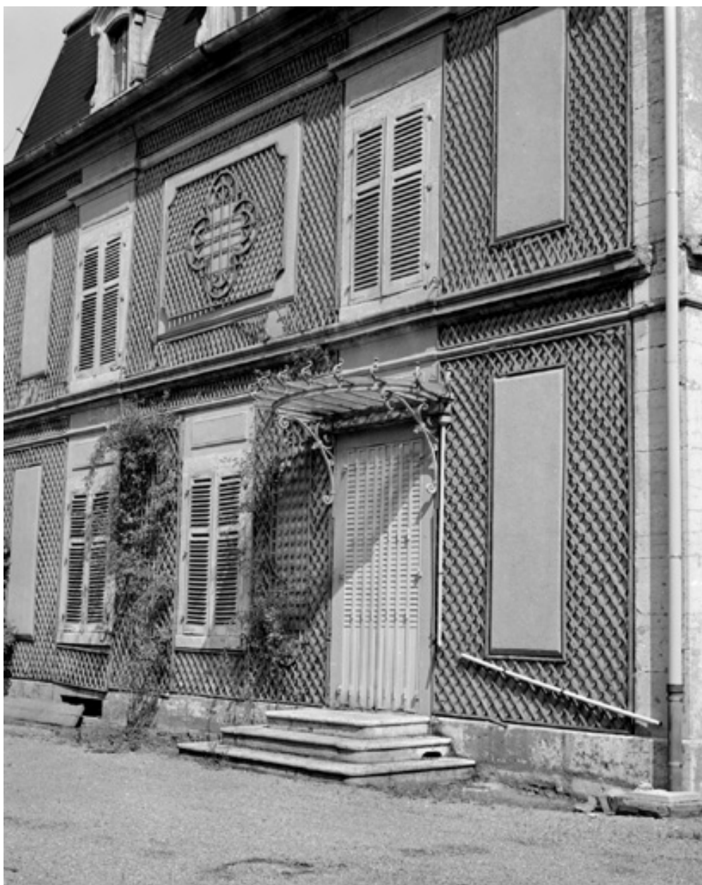
Détail de la façade ouest en 1981.SRI. Enquête régionale sur les bâtiments industriels (1979-1981).
