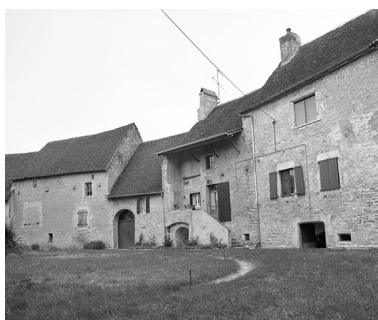
Détail : maisons section AI parcelles 97, 98, 99. Phot. Yves Sancey IVR43_19793900234X
