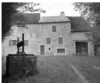
Détail : maisons section AI parcelles 96 et 97. Phot. Yves Sancey IVR43_19793900233X
