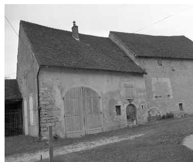
Détail : maisons section AI parcelles 104 et 99. Phot. Yves Sancey IVR43_19793900235X
