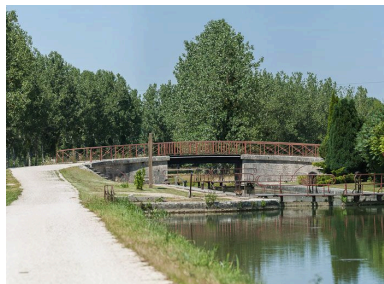
Le pont vu d'amont.
