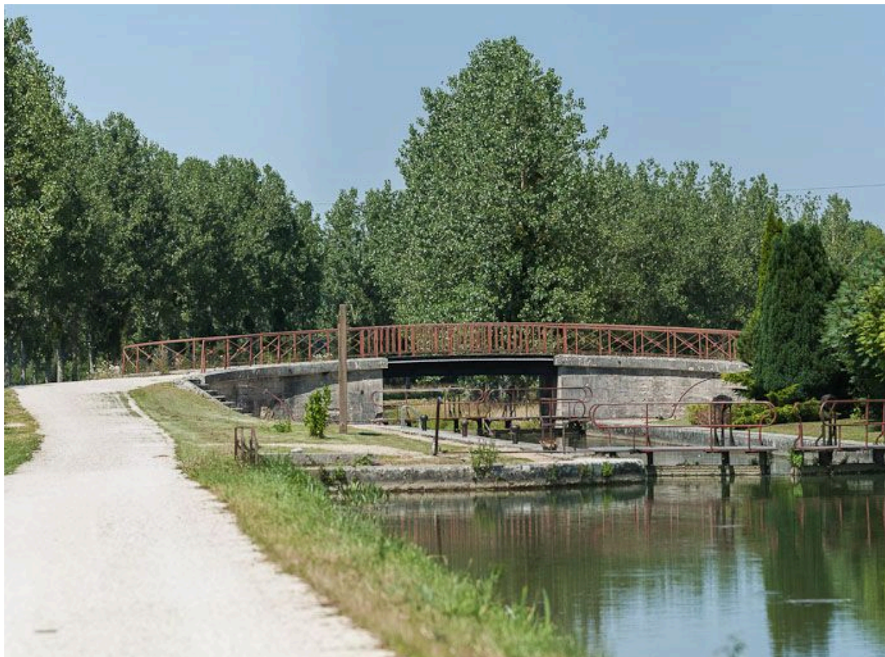
Le pont vu d'amont.
