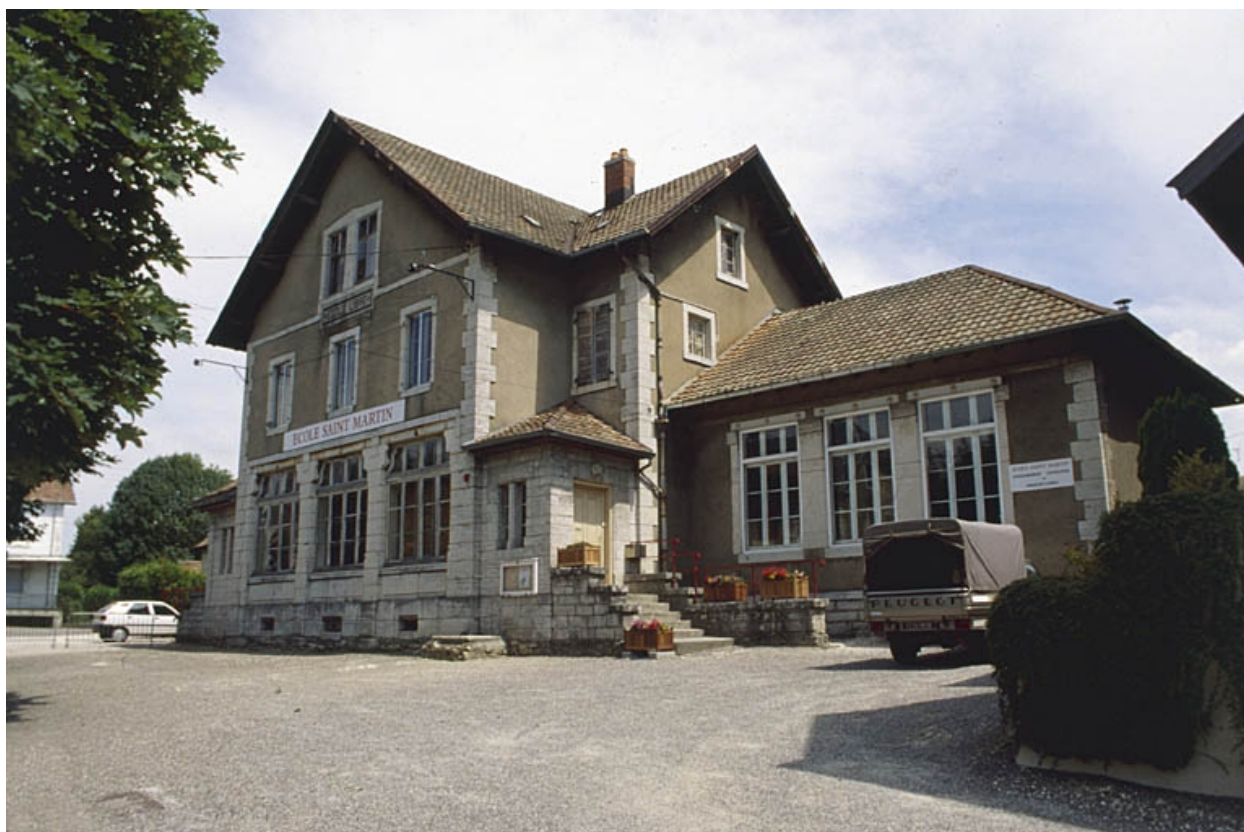
Façade antérieure depuis l'ouest.
