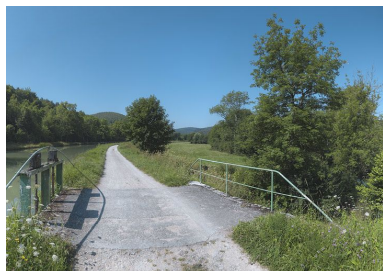
Vannes et garde corps du déversoir. Phot. Thierry Kuntz IVR26_20122102544NUC4A
