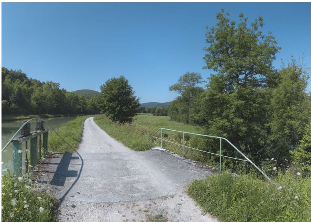
Vannes et garde corps du déversoir.
