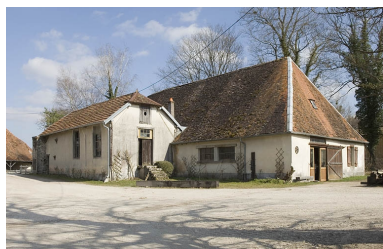
Halle à charbon Phot. Jérôme Mongreville IVR43_20097000217NUC2A
