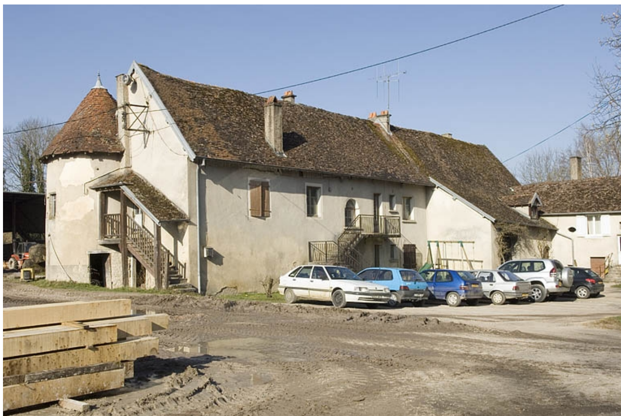
Logis sud. Vue de trois quarts.
