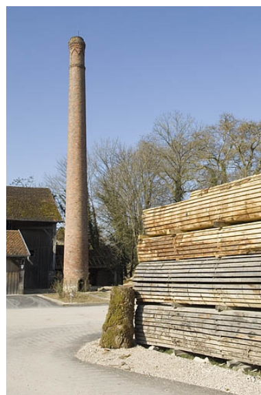
Cheminée depuis le nord-est. Phot. Jérôme Mongreville IVR43_20097000230NUC2A
