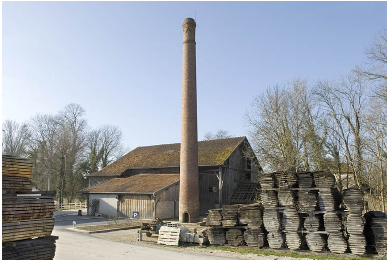
Vue d'ensemble de l'entrée depuis le nord-ouest.
