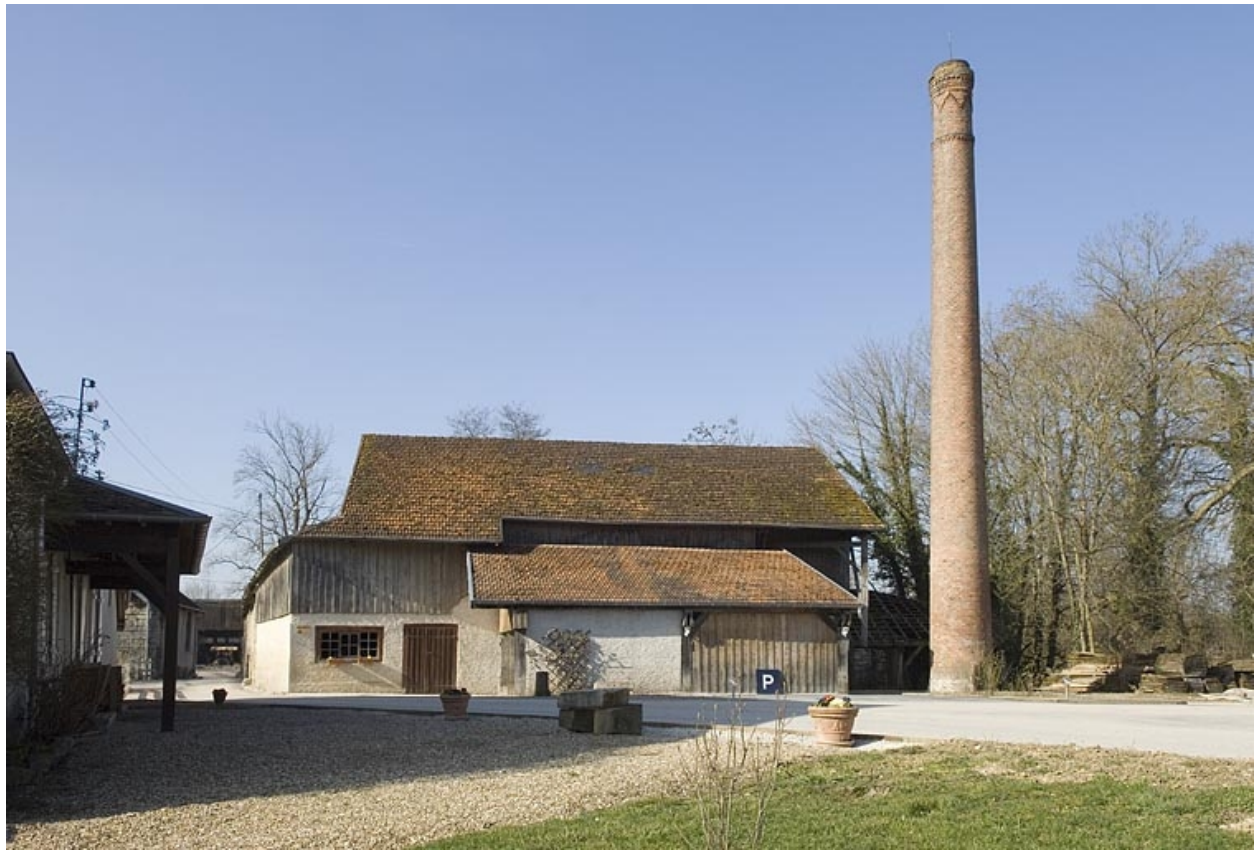
Magasin industriel et cheminée depuis le nord-est.
