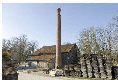
Vue d'ensemble de l'entrée depuis le nord-ouest. Phot. Jérôme Mongreville IVR43_20097000222NUC2A
