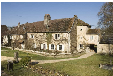
Vue d'ensemble de la demeure patronale. Phot. Jérôme Mongreville IVR43_20097000227NUC2A
