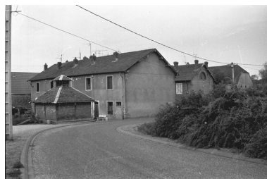
Logement ouvrier à gauche de la rue en 1987: façade postérieure de trois-quarts droit, et lieux d'aisance. Phot. Yves Sancey IVR43_19877000148Z
