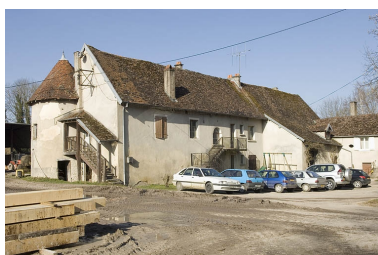
Logis sud. Vue de trois quarts. Phot. Jérôme Mongreville IVR43_20097000224NUC2A
