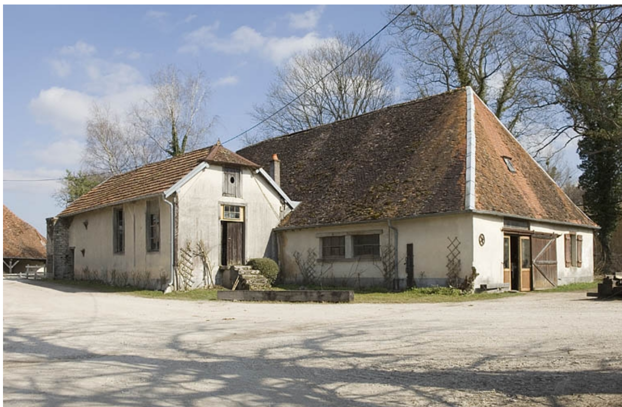
Halle à charbon
