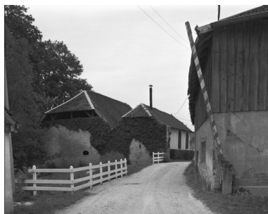
Halle à charbon sud depuis l'entrée en 1989. Phot. Yves Sancey IVR43_19897000848X
