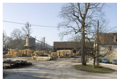
Le chantier de la scierie. Phot. Jérôme Mongreville IVR43_20097000228NUC2A
