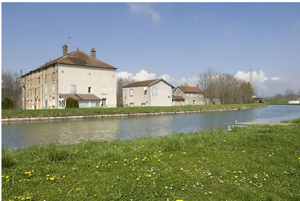
Vue rapprochée depuis le sud-est.
