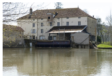
Façade antérieure depuis l'amont. Phot. Jérôme Mongreville IVR43_20087000520NUC2A
