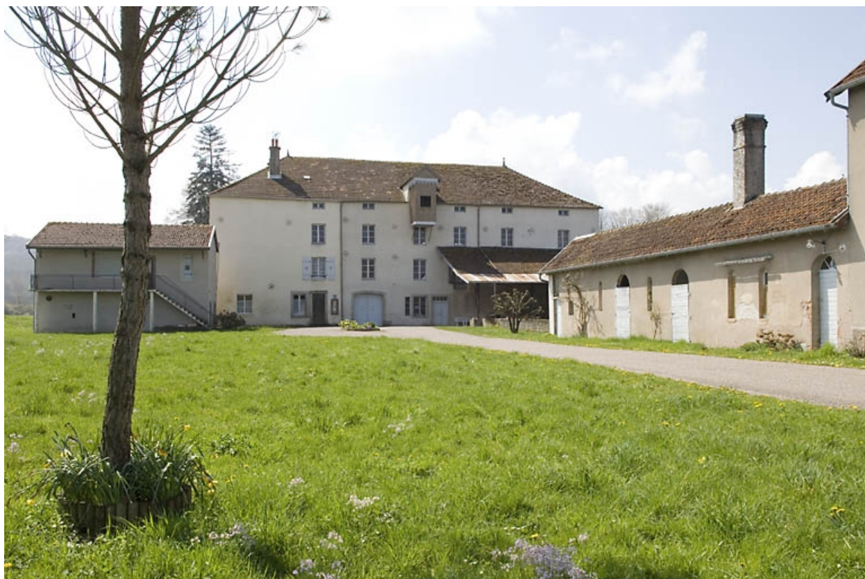
Façade antérieure et dépendances depuis l'entrée.
