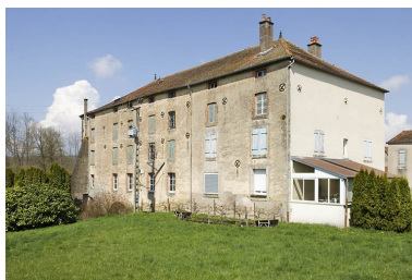
Façade postérieure vue de trois quarts arrière. Phot. Jérôme Mongreville IVR43_20087000515NUC2A
