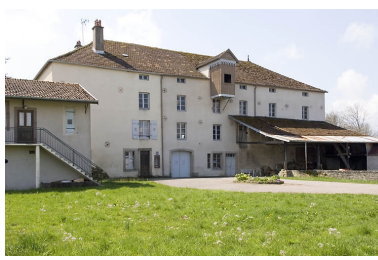
Façade antérieure. Phot. Jérôme Mongreville IVR43_20087000512NUC2A
