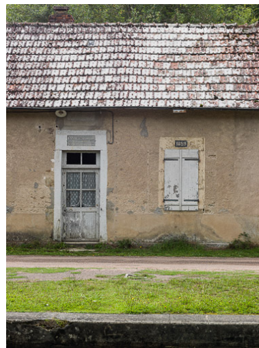
Détail des ouvertures de la maison éclusière. Phot. Pierre-Marie Barbe-Richaud IVR26_20175800294NUC2A
