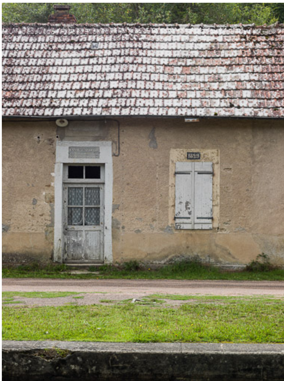
Détail des ouvertures de la maison éclusière.
