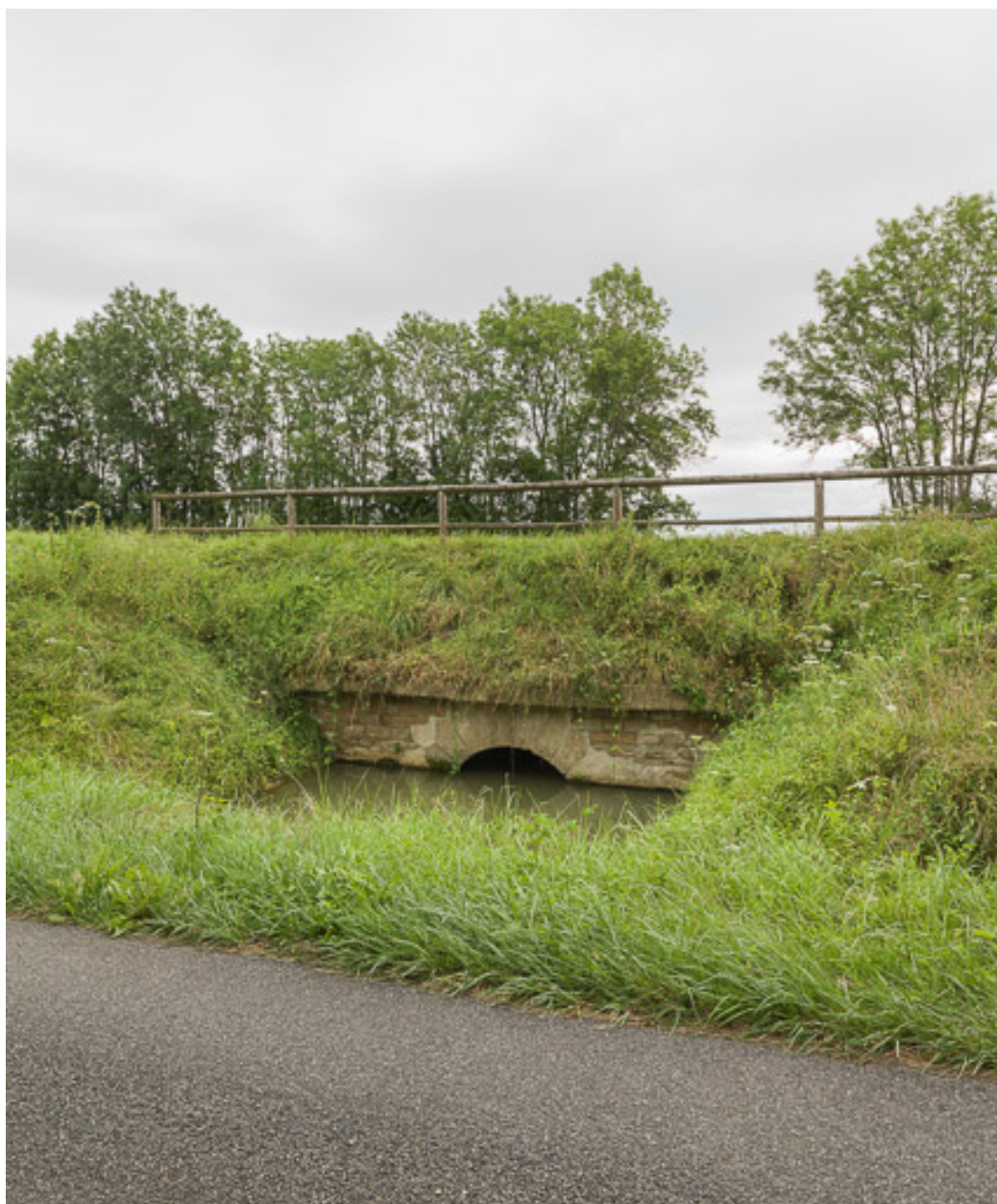
Vue de l'aqueduc.
