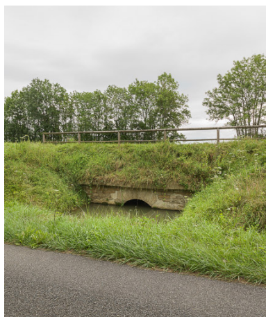
Vue de l'aqueduc. Phot. Pierre-Marie Barbe-Richaud IVR26_20175800177NUC2A
