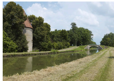
Le pont vu d'aval. A gauche : une tour du château. Phot. Thierry Kuntz IVR26_20135800306NUC4A
