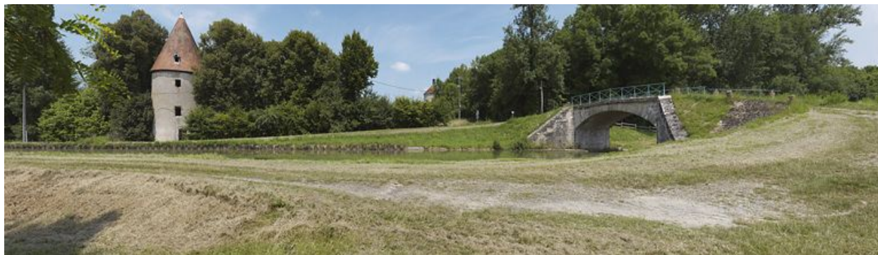
Le pont vu d'aval. A gauche : une tour du château.
