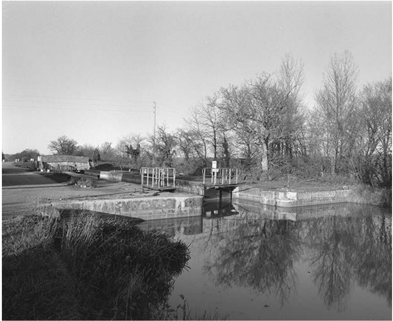
Vue d'ensemble prise de l'amont.
