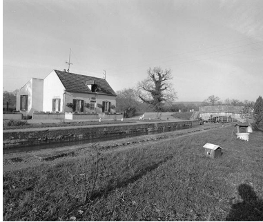
Vue d'ensemble prise de l'amont. Phot. Jean-Luc Duthu IVR26_19925800201X
