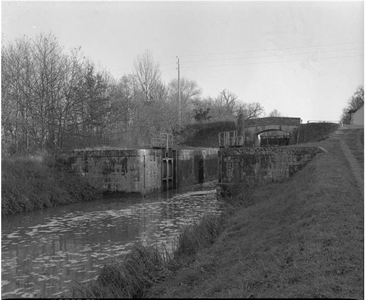
Le pont et l'écluse. Vue d'ensemble.
