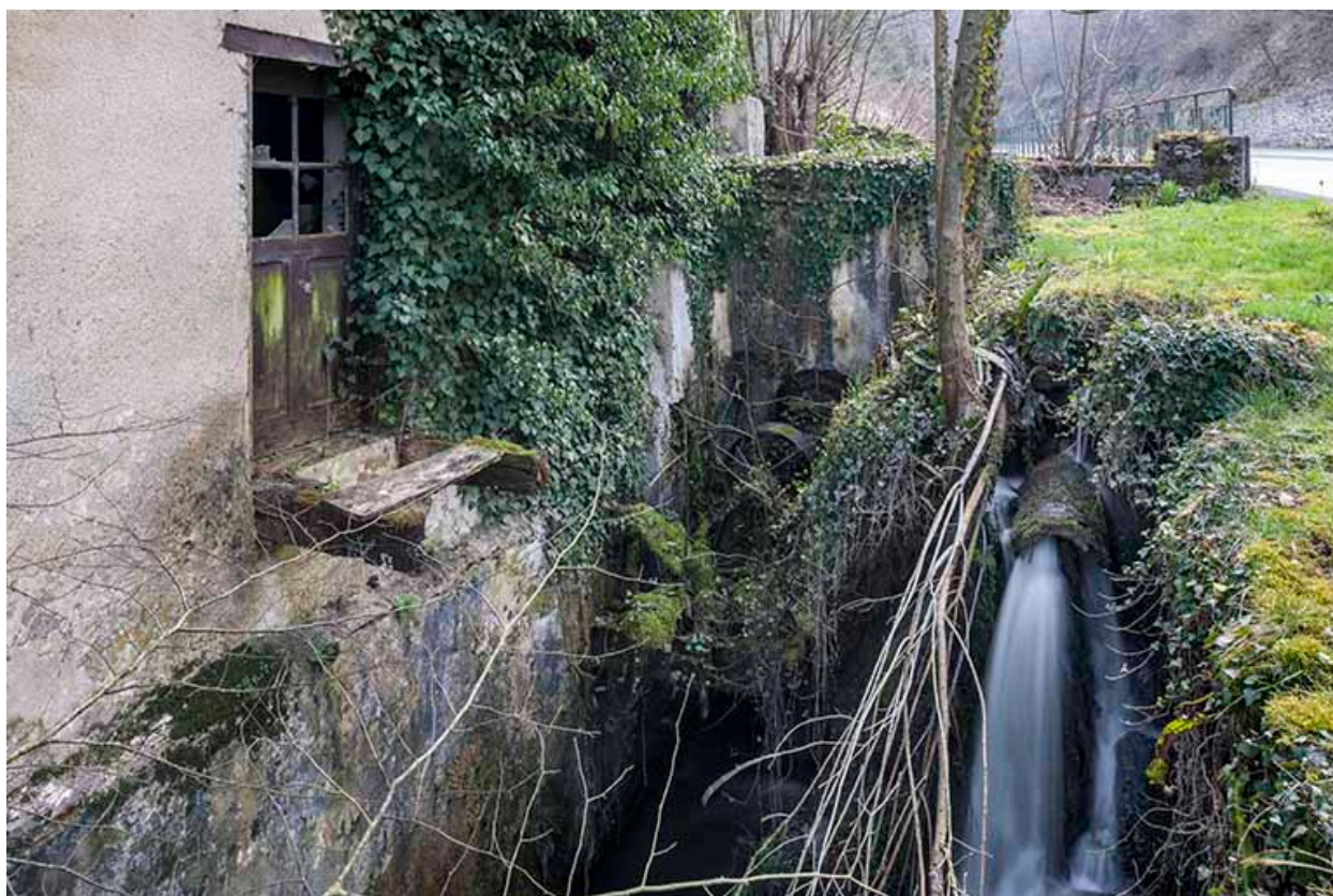
Canal d'amenée et vestiges de la turbine.
