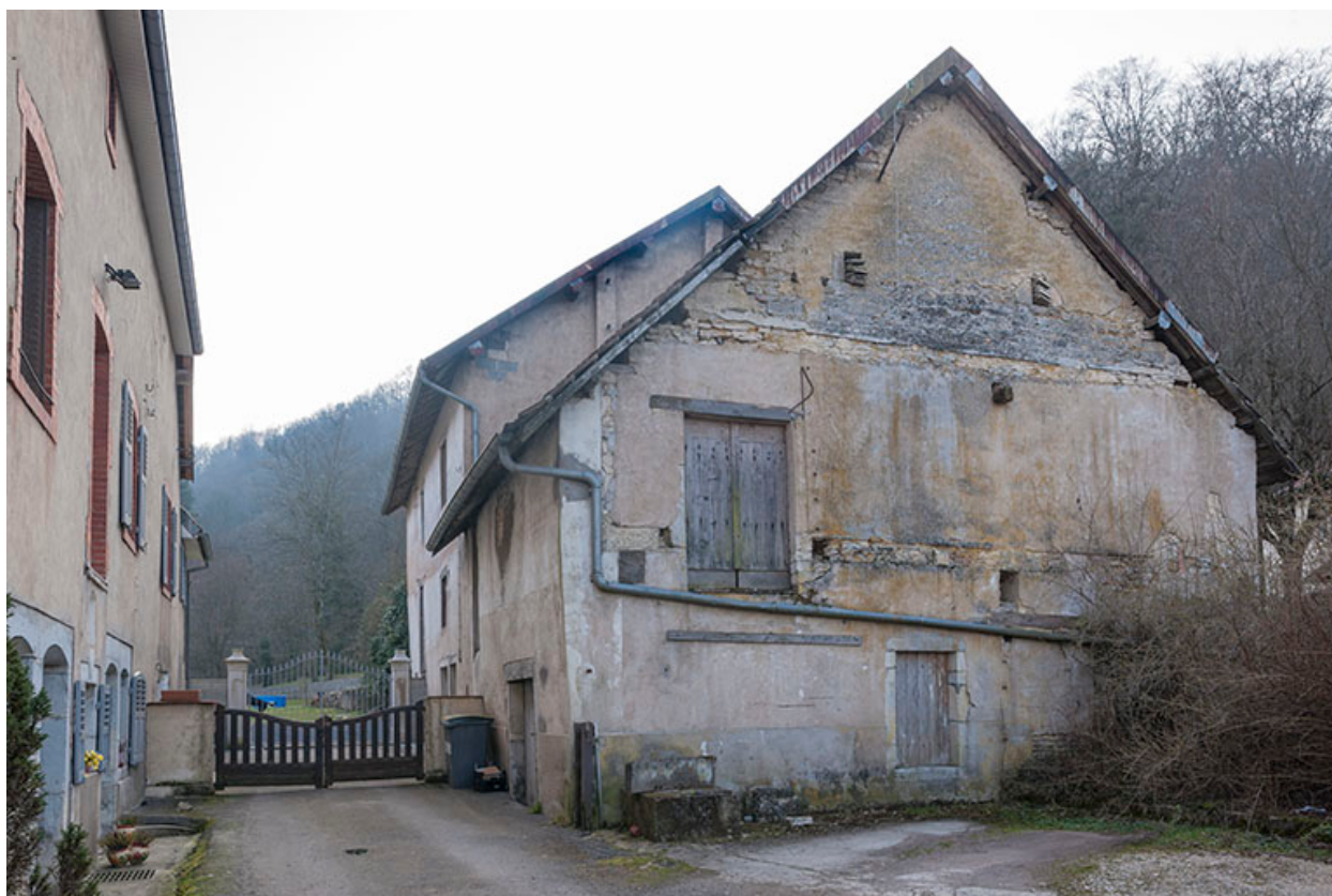
Façade est et pignon nord.
