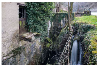
Canal d'amenée et vestiges de la turbine. Phot. Jérôme Mongreville
