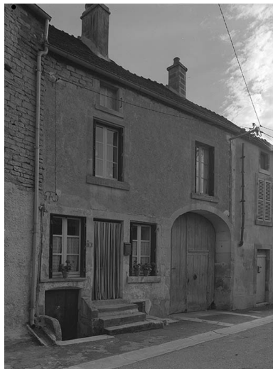
Façade sur rue. Phot. Jean-Luc Duthu IVR26_19748901263V
