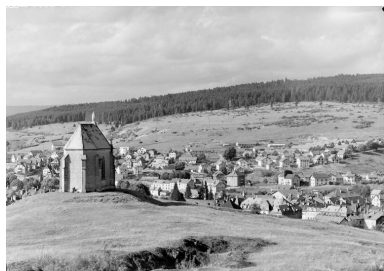
Façade postérieure [1e moitié du 20e siècle]. Autr. Jules Manias IVR43_20062501033P
