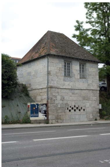
Corps de garde, depuis l'avenue Gaulard. La baie bouchée conduit, via un tunnel voûté, à une porte ouvrant la courtine sur le chemin de halage.
