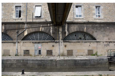
Baies des casemates, à l'étage de soubassement. Phot. Yves Sancey IVR43_20062500305NUCA
