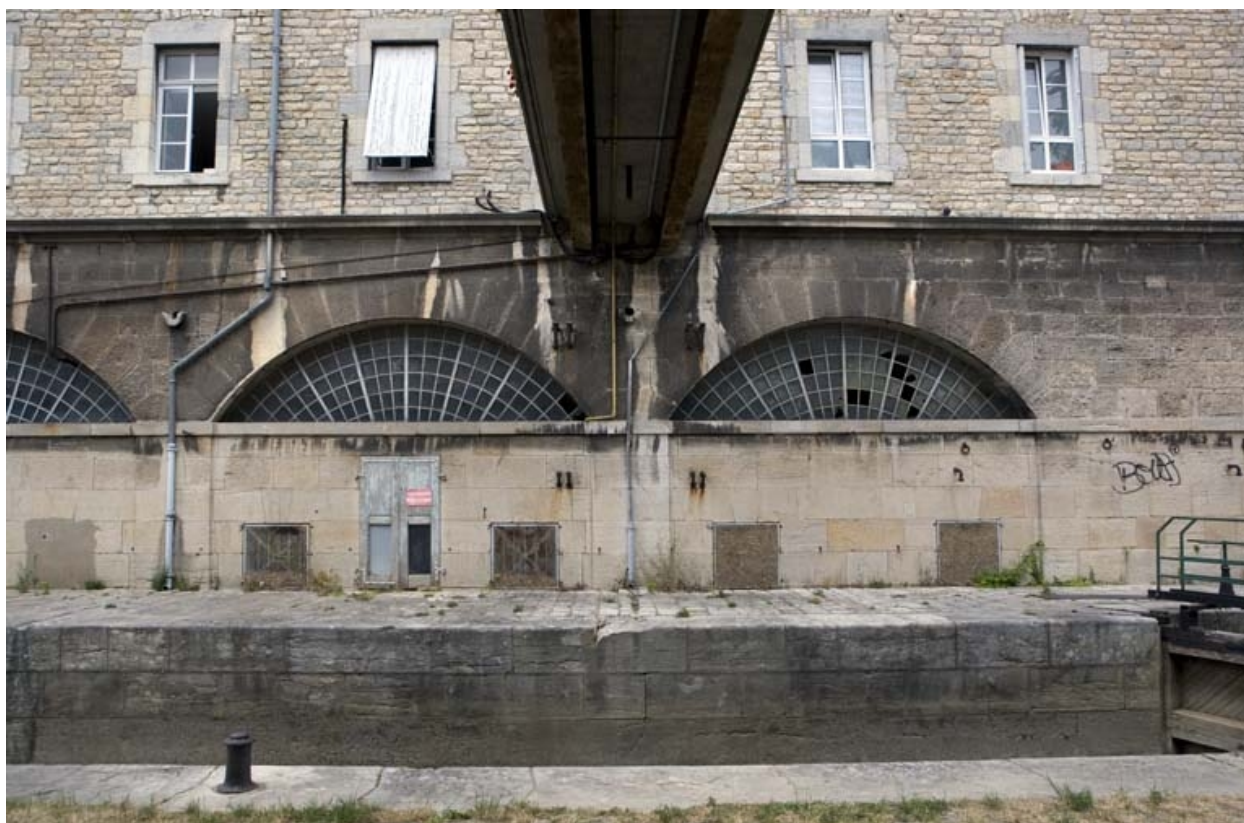
Baies des casemates, à l'étage de soubassement.
