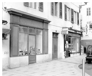
Rez-de-chaussée de l'élévation antérieure. Phot. Yves Sancey IVR43_20033900568X
