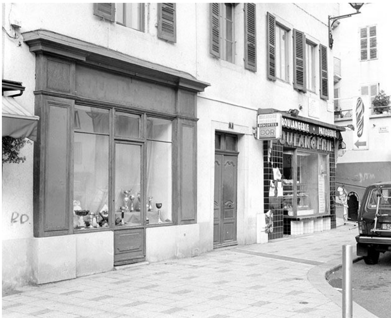
Rez-de-chaussée de l'élévation antérieure.
