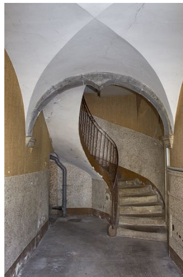
Couloir voûté et escalier. Phot. Yves Sancey IVR43_20103900628NUC2A
