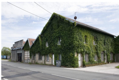
Atelier, bureau et logement depuis l'ouest. Phot. Jérôme Mongreville IVR43_20112502158NUC4A
