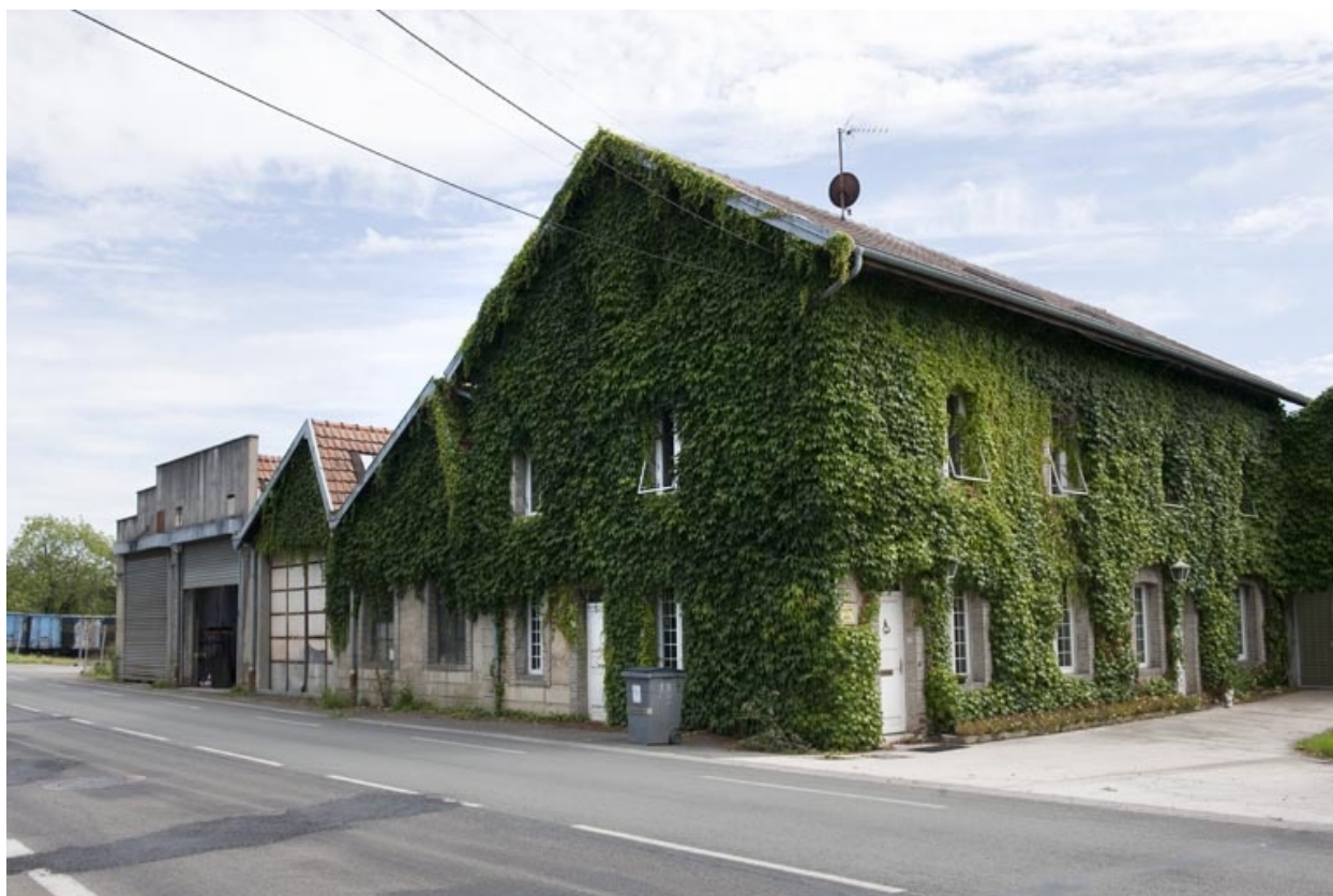
Atelier, bureau et logement depuis l'ouest.
