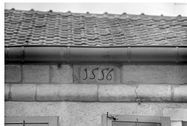
Façade sur rue, détail de la corniche. Phot. Jérôme Mongreville IVR43_19872500571X
