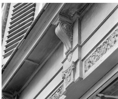
Façade sur rue, vestige de l'ancienne devanture. Phot. Jérôme Mongreville IVR43_19872500570X
