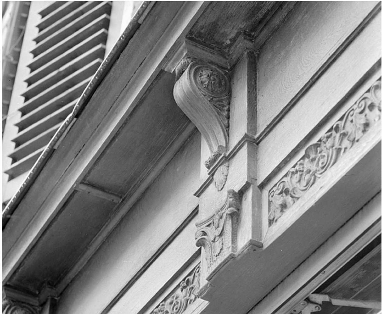
Façade sur rue, vestige de l'ancienne devanture.
