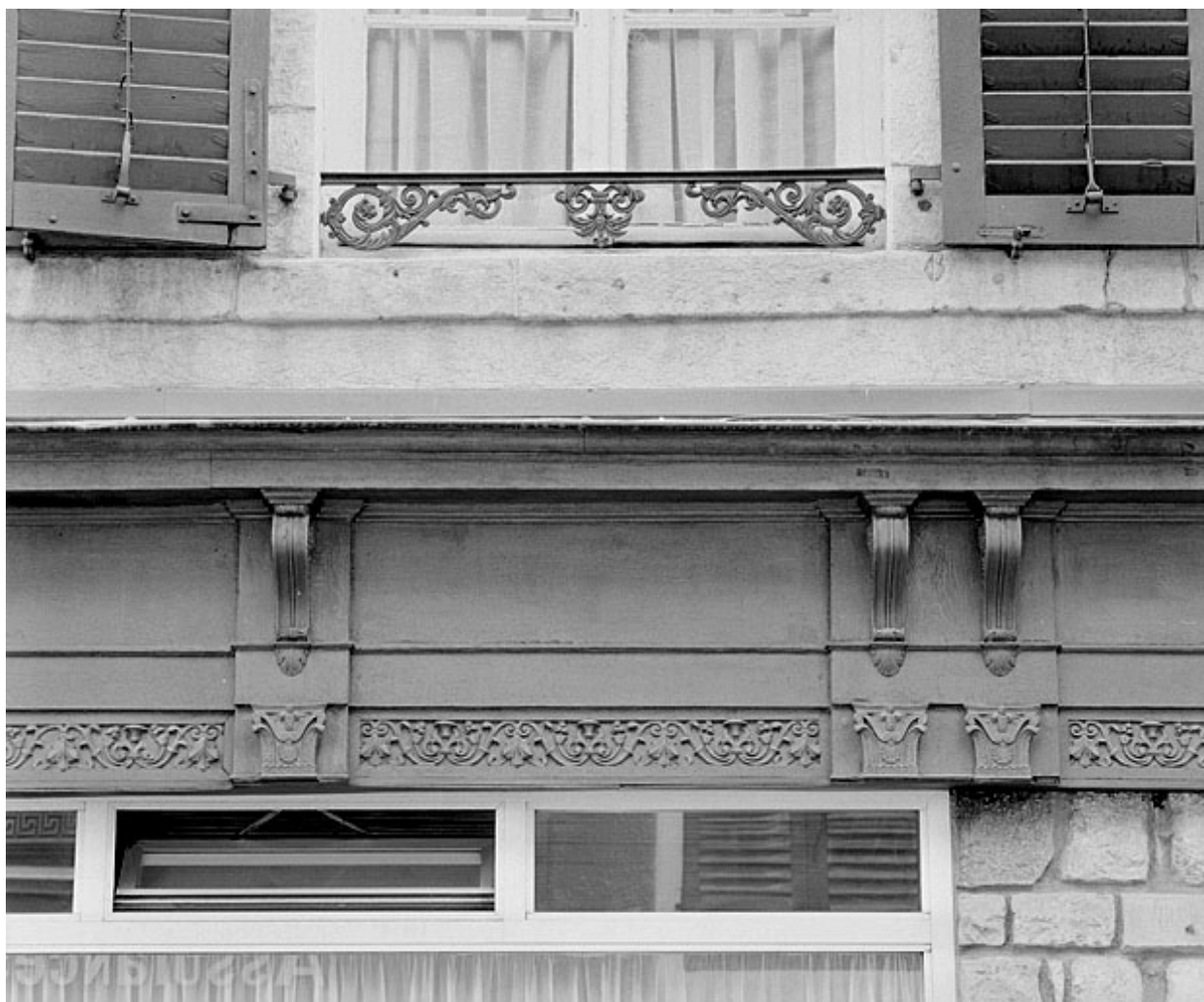
Façade sur rue, vestige de l'ancienne devanture.
