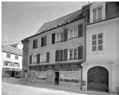
Façade sur rue. Phot. Jérôme Mongreville IVR43_19872501078V
