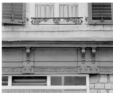
Façade sur rue, vestige de l'ancienne devanture. Phot. Jérôme Mongreville IVR43_19872500569X
