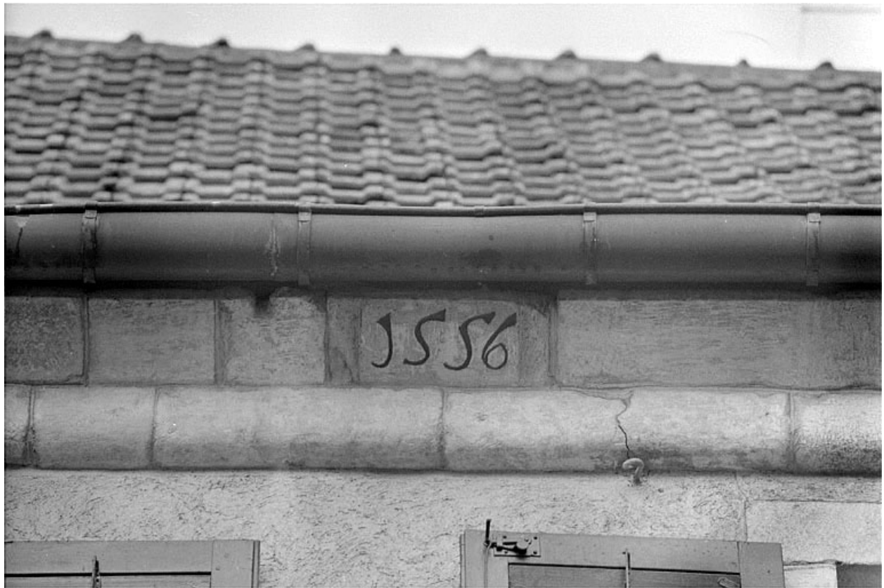
Façade sur rue, détail de la corniche.
