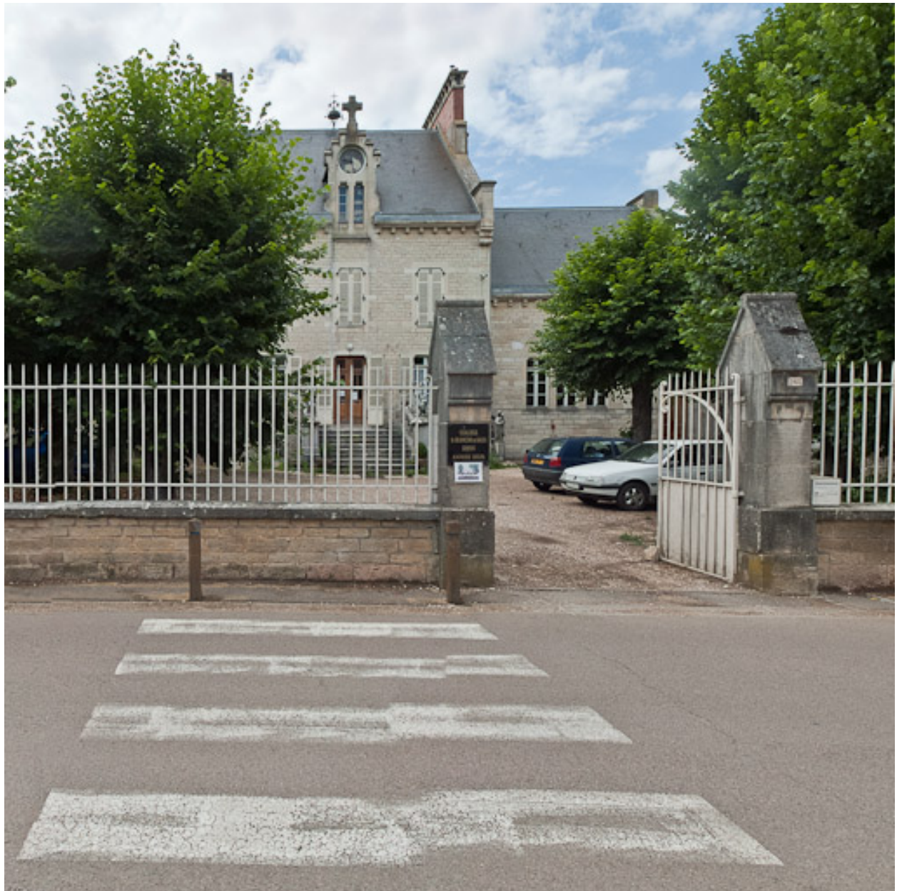
Vue du pensionnat depuis la route.
