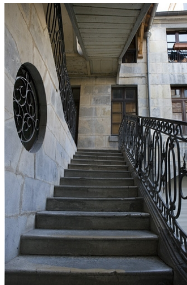
Détail de la première volée de l'escalier à cage ouverte. Phot. Yves Sancey IVR43_20072500162NUCA
