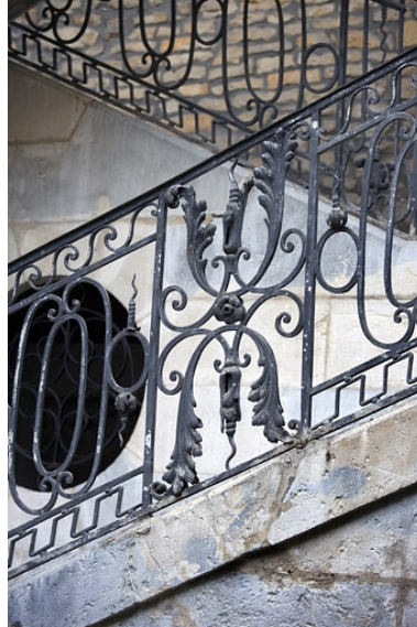
Détail d'une partie du décor de la rampe de l'escalier. Phot. Yves Sancey IVR43_20072500165NUCA
