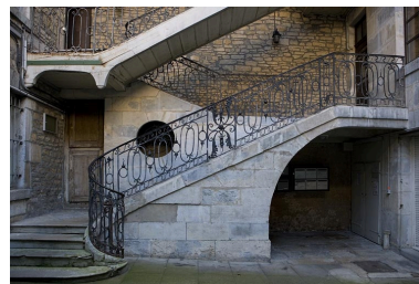
Détail de la première volée de l'escalier à cage ouverte depuis la cour. Phot. Yves Sancey IVR43_20072500160NUCA
