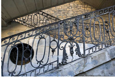
Détail de la rampe en fer forgé de l'escalier à cage ouverte. Phot. Yves Sancey IVR43_20072500163NUCA
