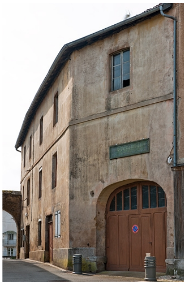
Vue générale de la façade antérieure.
