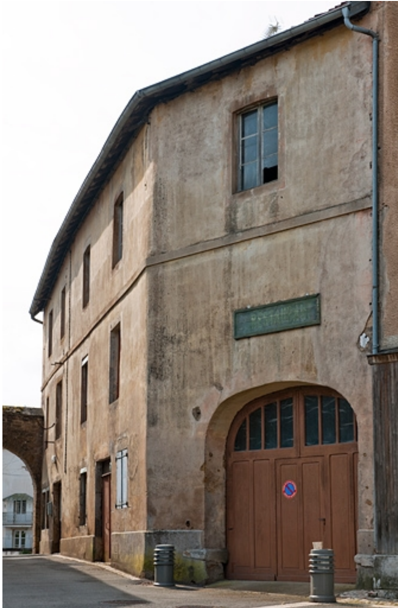
Vue générale de la façade antérieure.
