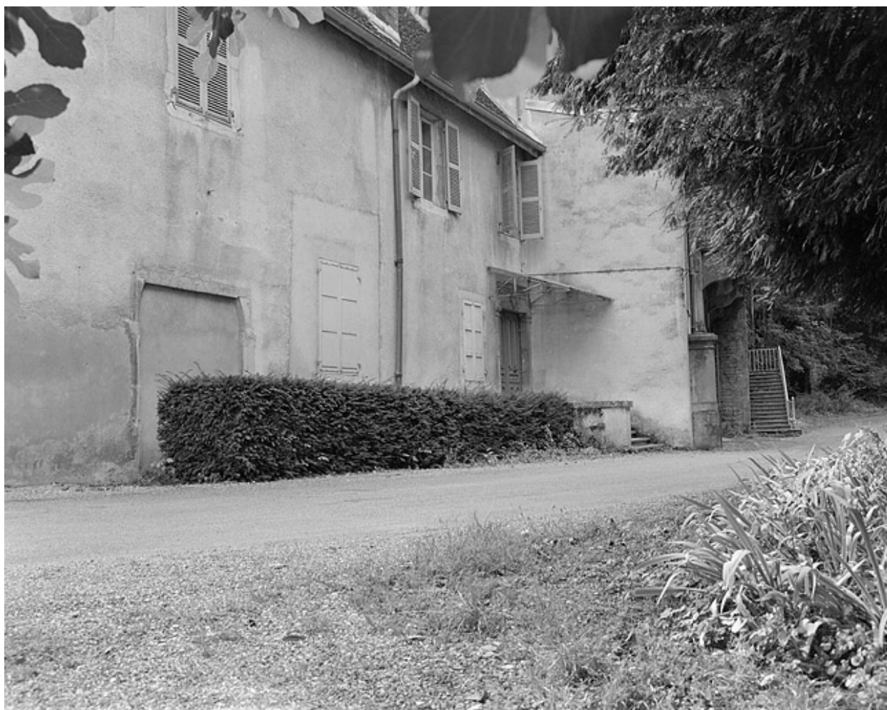
Façade latérale droite du bâtiment A.
