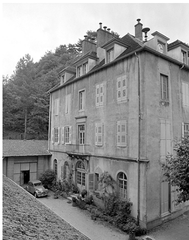
Façade antérieure du bâtiment C.
