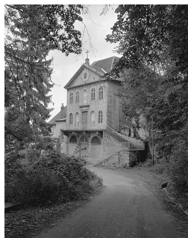
Façade antérieure du bâtiment B. Phot. Yves Sancey IVR43_19833900344X
