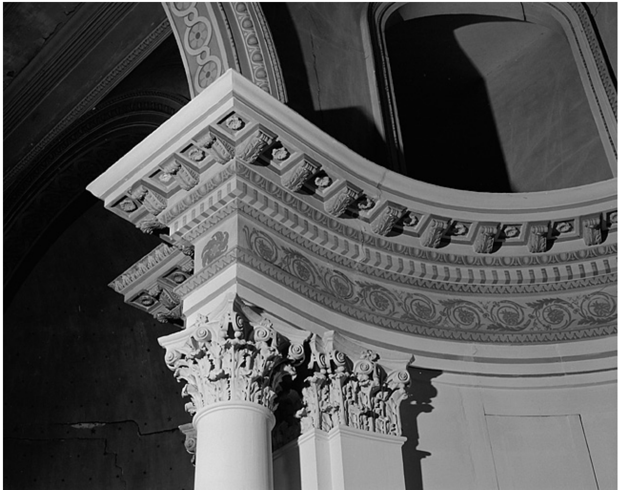
Chapelle II, détail de l'entablement du vaisseau.
