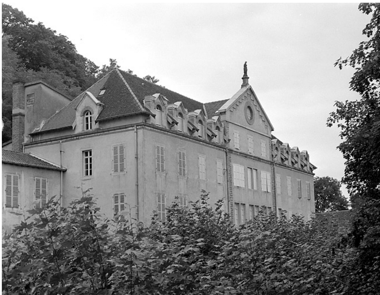
Façade antérieure du bâtiment D.
