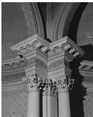
Chapelle II, détail de l'entablement du chœur. Phot. Yves Sancey
