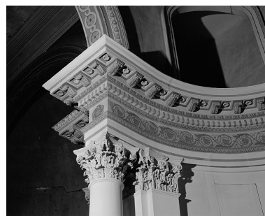
Chapelle II, détail de l'entablement du vaisseau. Phot. Yves Sancey IVR43_19833900429X
