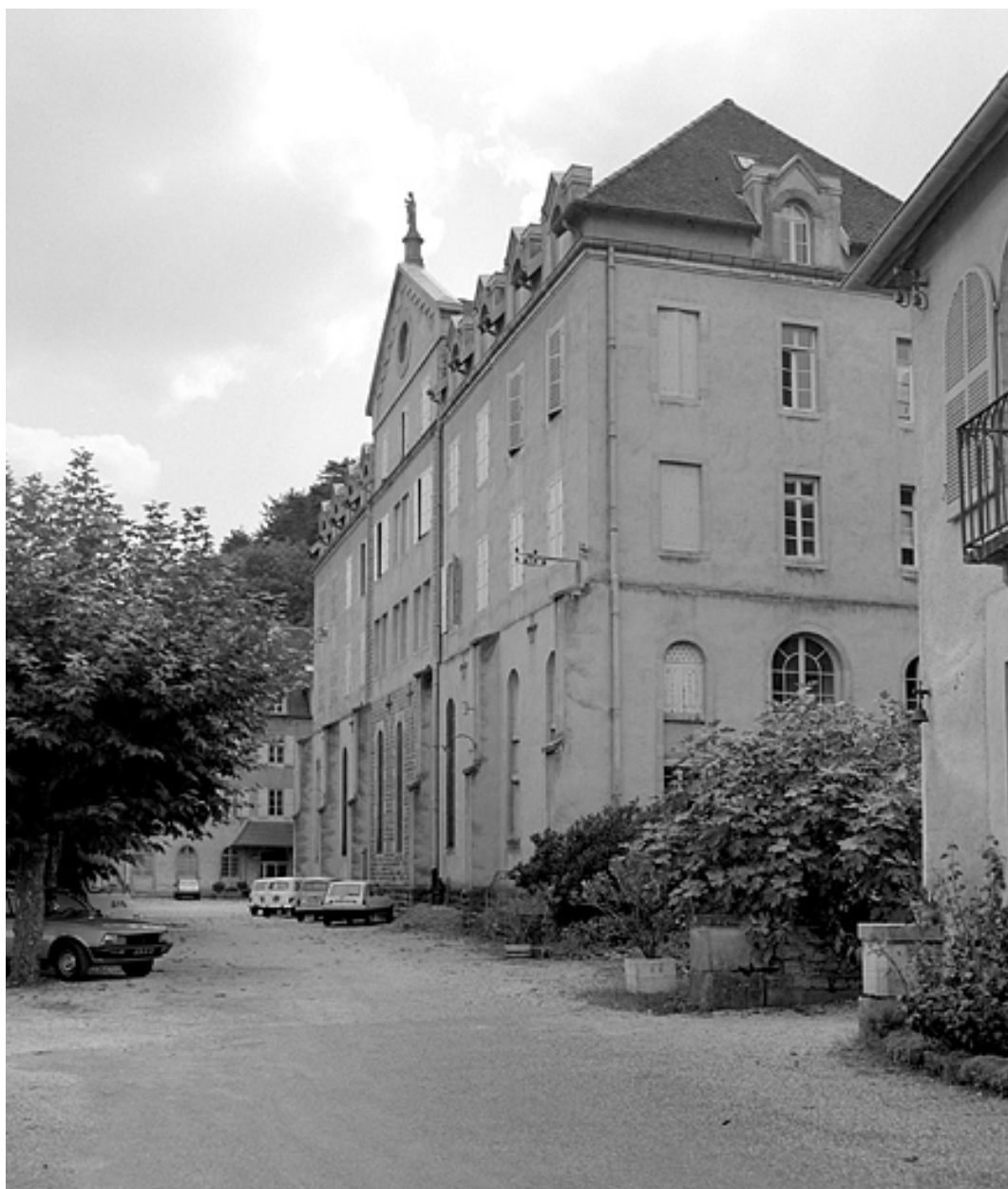
Vue de trois-quarts du bâtiment D.
