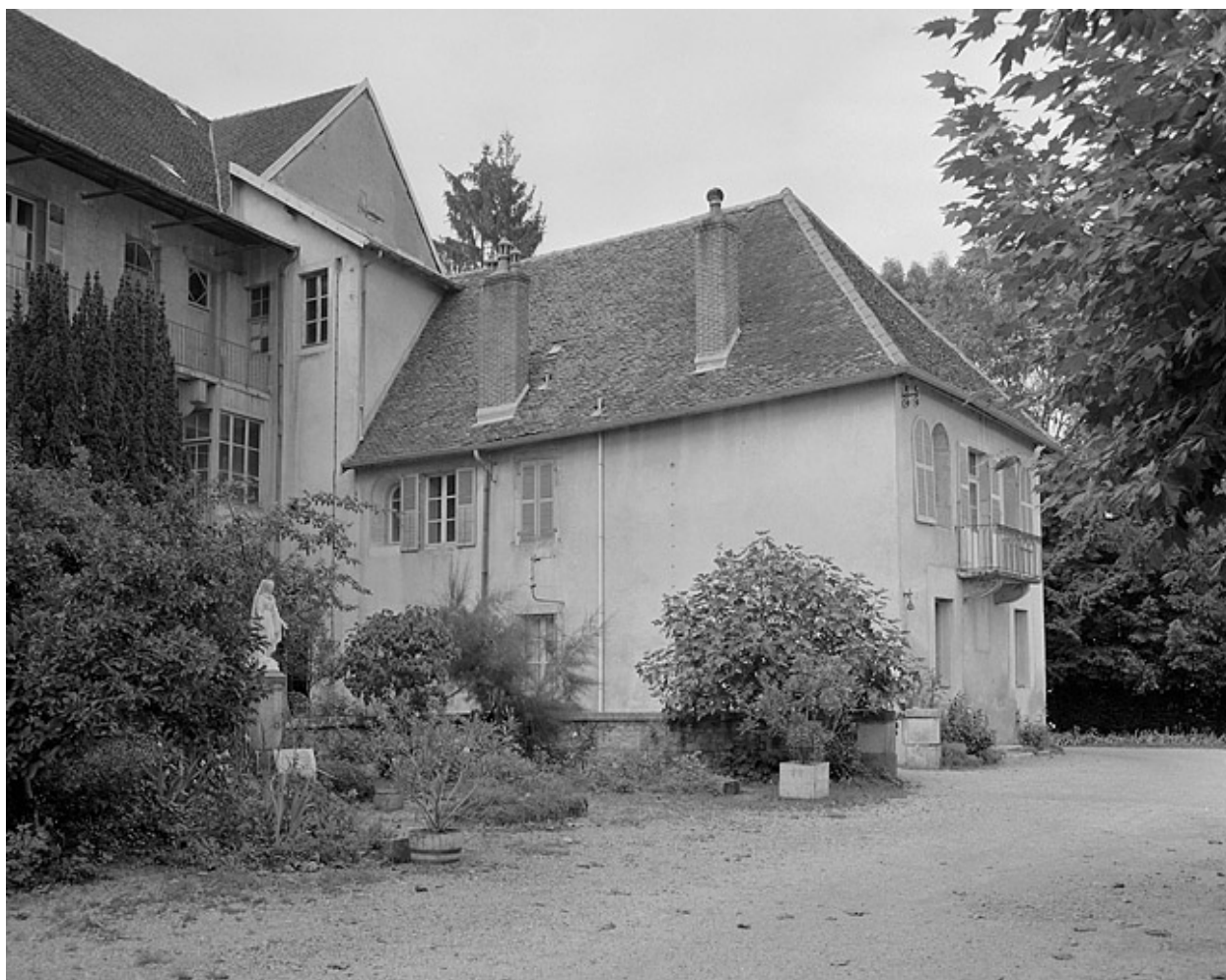
Façade latérale gauche du bâtiment A.
