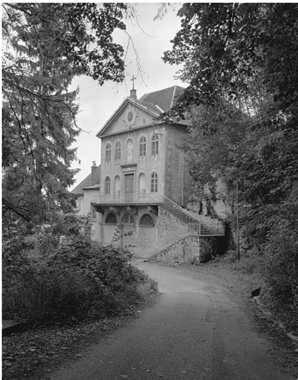
Façade antérieure du bâtiment B.
