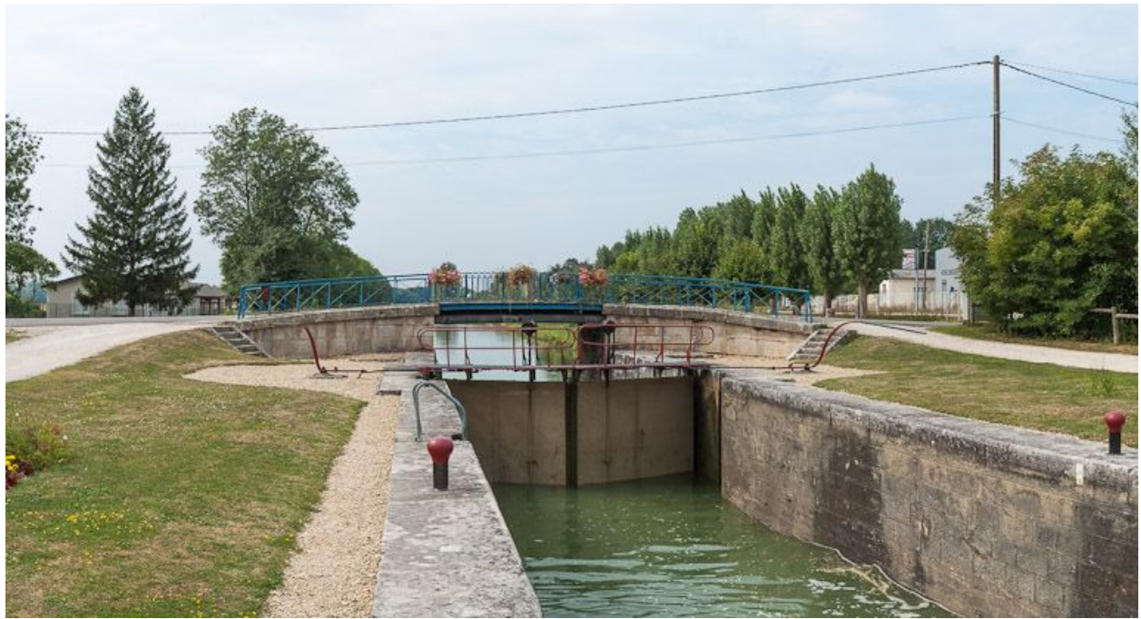
Vue du pont depuis le sas.
