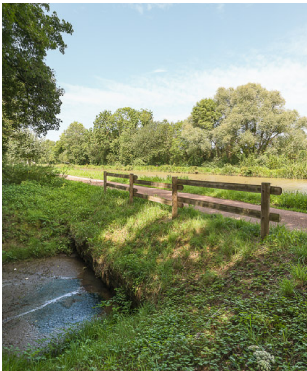
Vue de l'aqueduc.
