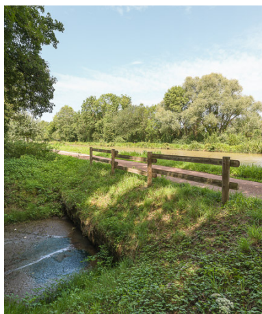
Vue de l'aqueduc.
