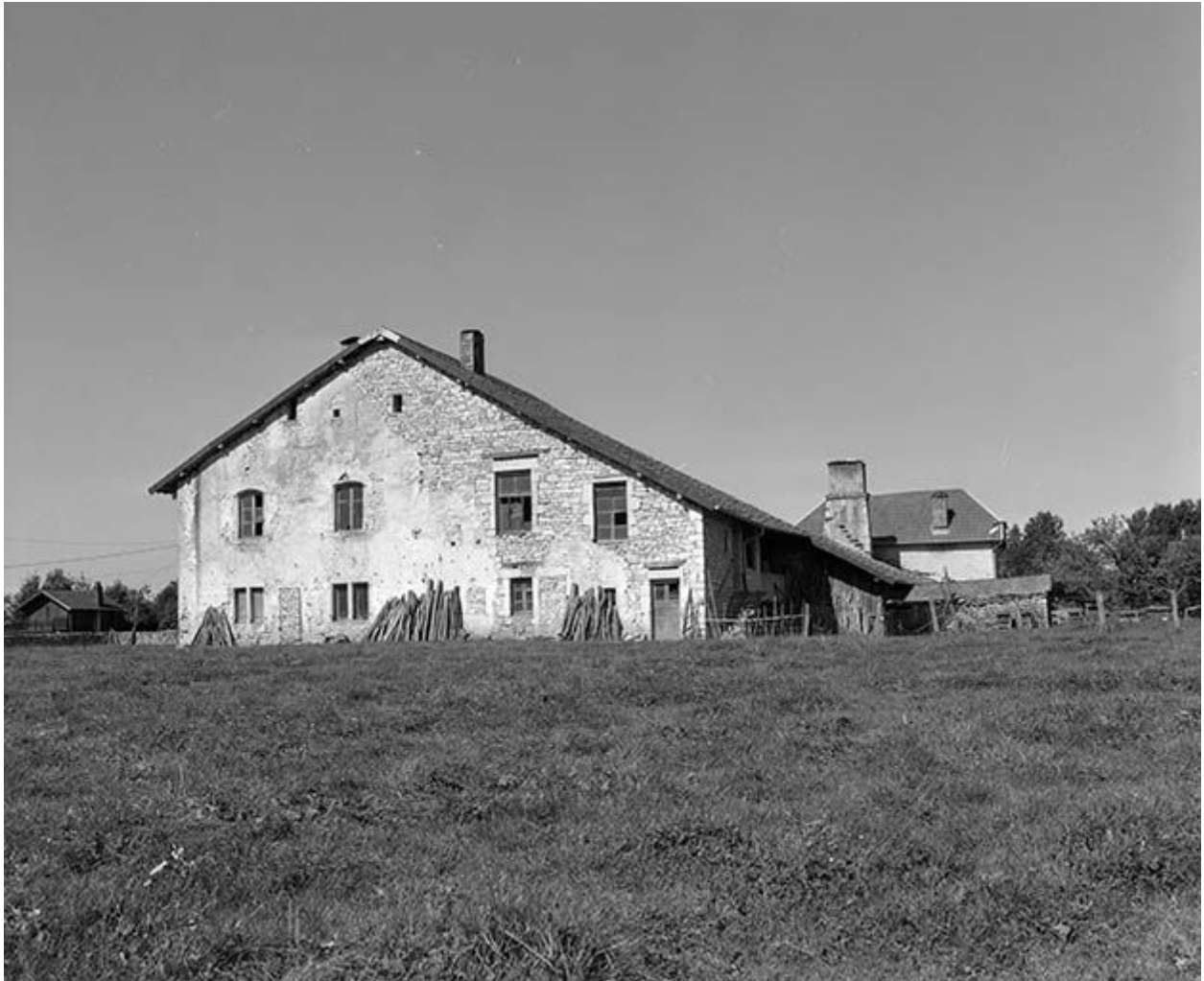
Façade antérieure et face latérale droite.
