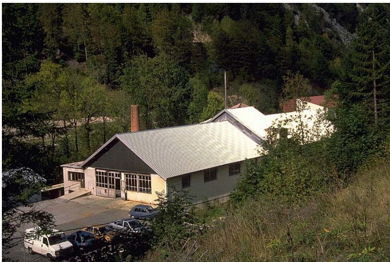
Vue plongeante sur la façade antérieure.
