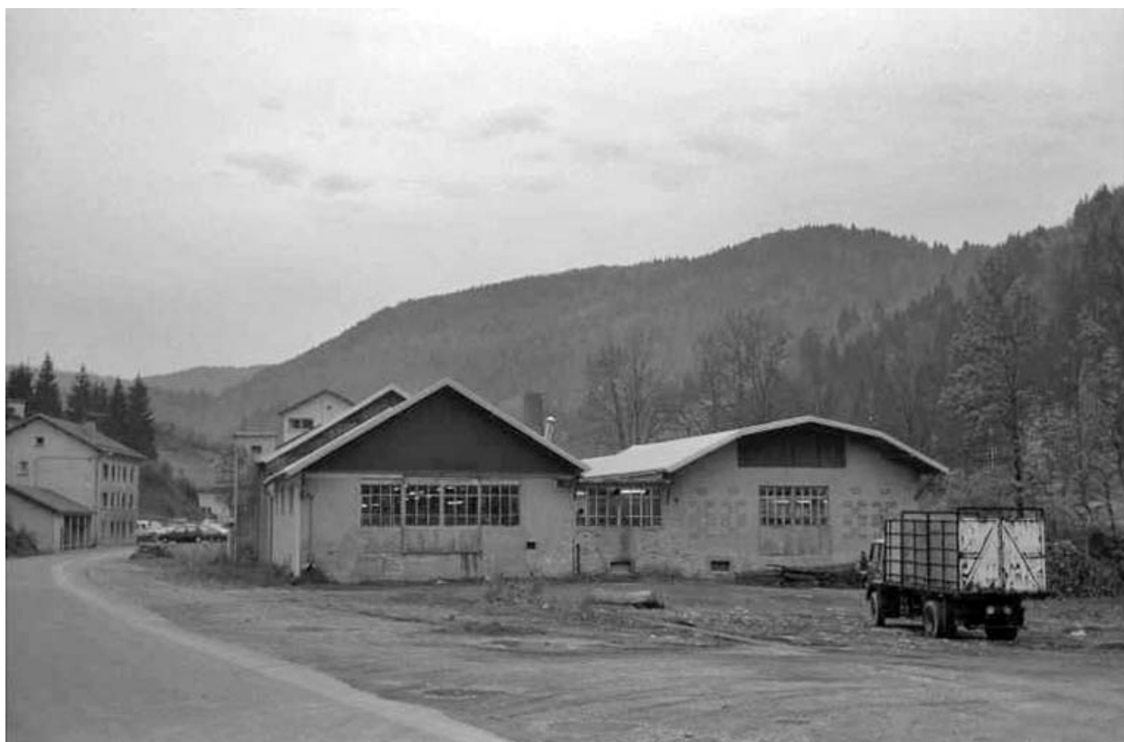
Vue d'ensemble de la façade postérieure.
