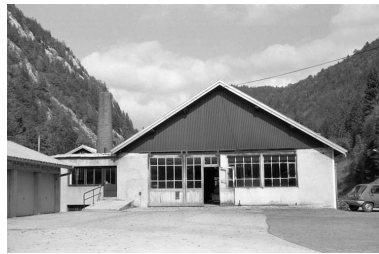
Façade antérieure. Phot. Laurent Poupard IVR43_19903900648Z
