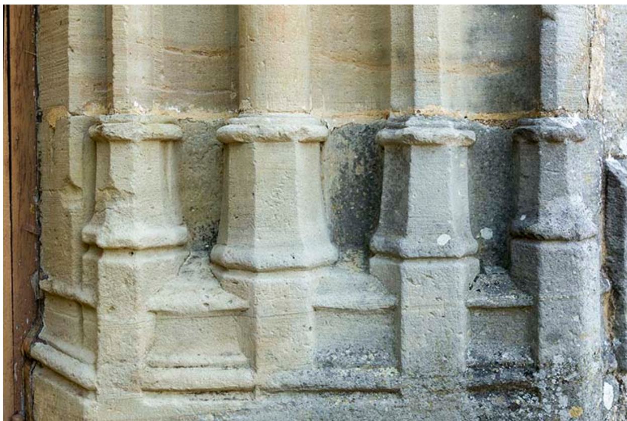
Détail de la base du piedroit droit.
