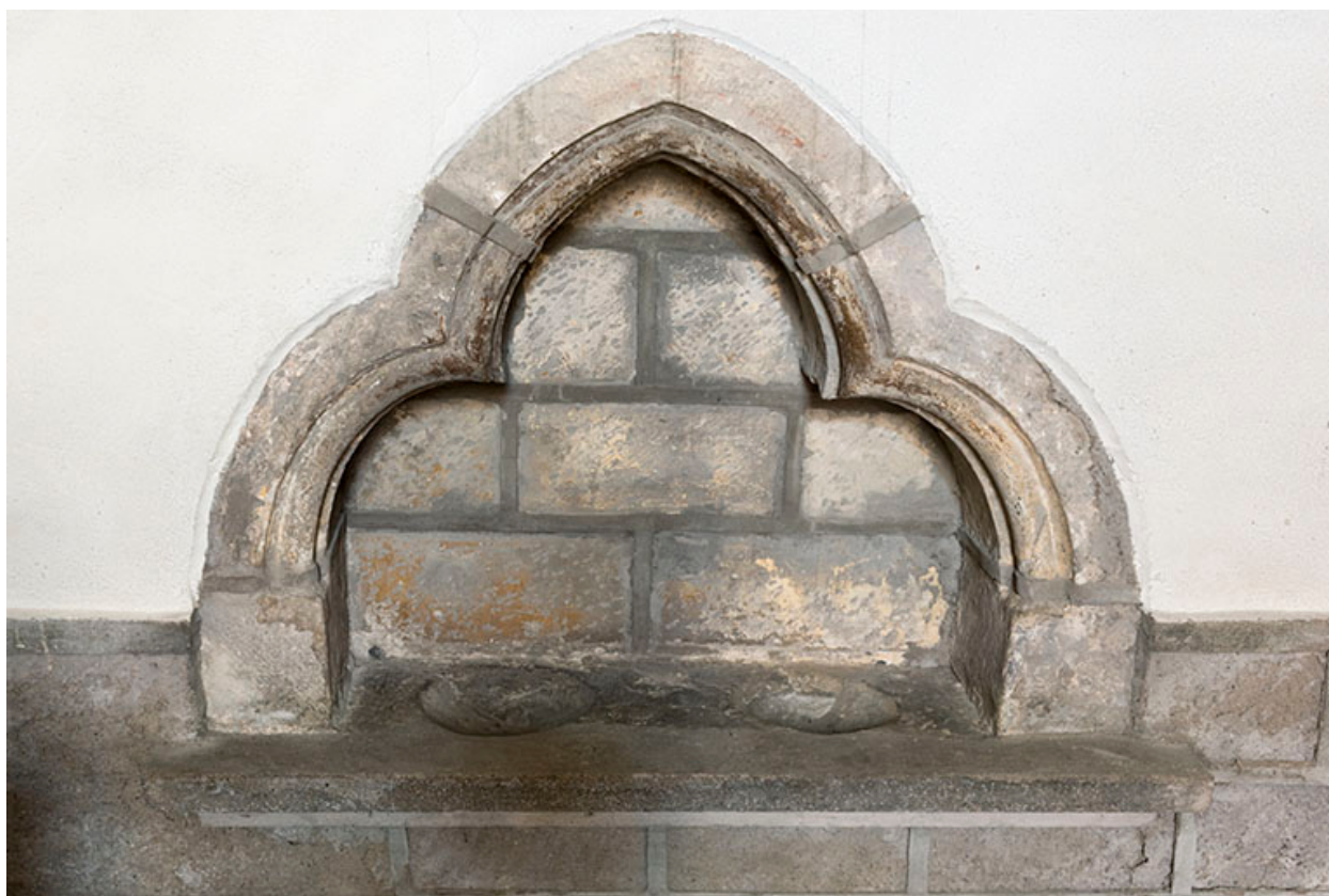
Détail : niche trilobée à droite du chœur.
