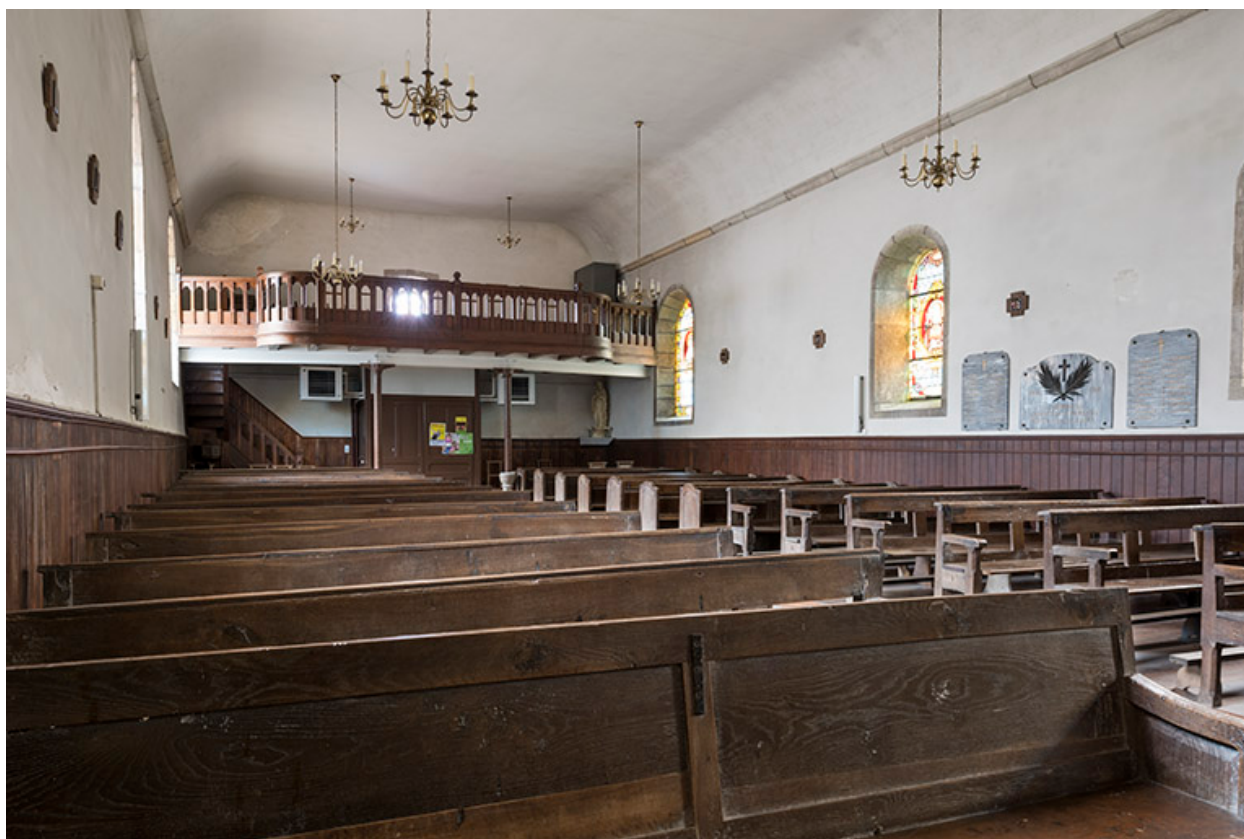
Vue de trois-quart depuis l'angle est.
