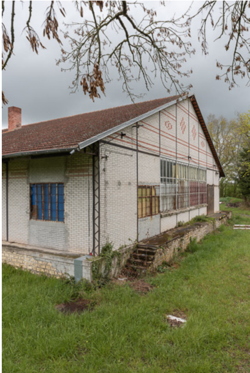
Bâtiment de l'embouteillage construit en 1928, mur pignon est et ancien quai de chargement sud.
