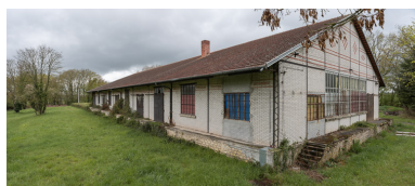
Bâtiment de l'embouteillage construit en 1928, mur pignon est et ancien quai de chargement sud. Phot. Pierre-Marie Barbe-Richaud IVR26_20195800253NUC4A
