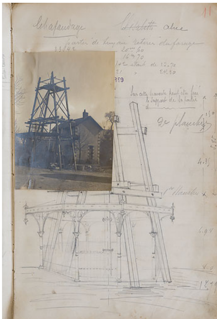
Échafaudage construit pour le forage de la source Alice en 1899.
