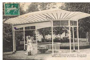
Buvette Alice et maison du régisseur (à l'arrière). Phot. Pierre-Marie Barbe- Richaud, Autr. auteur inconnu IVR26_20205800018NUC4A
