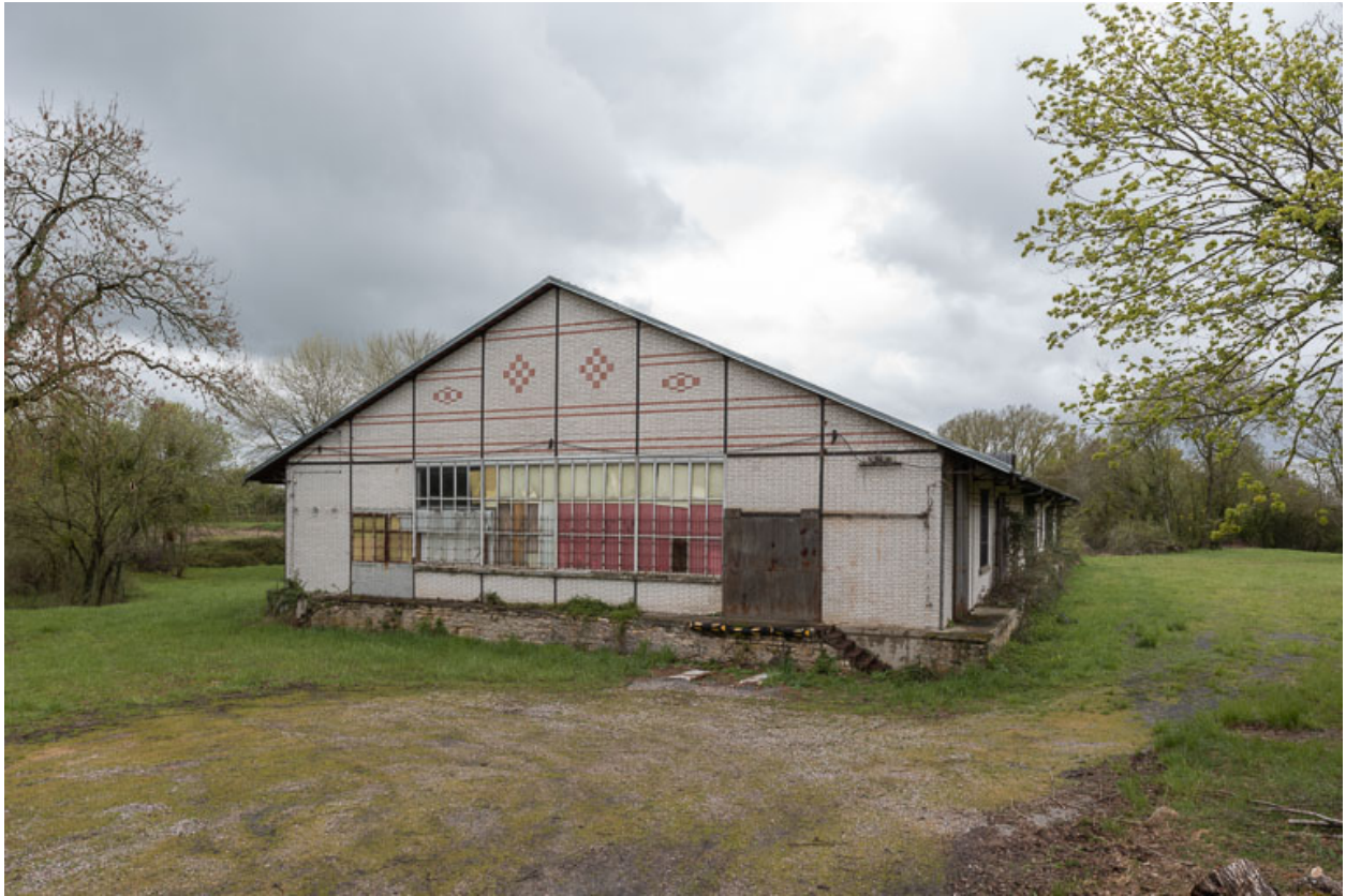
Bâtiment de l'embouteillage construit en 1928, mur pignon est et ancien quai de chargement nord.
