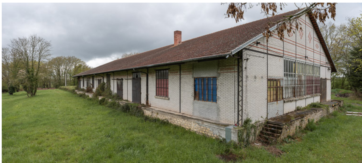
Bâtiment de l'embouteillage construit en 1928, mur pignon est et ancien quai de chargement sud.
