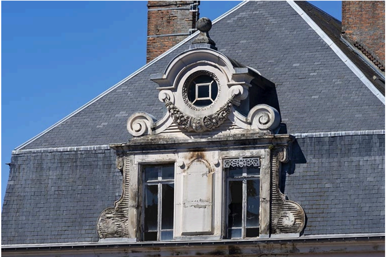
Façade est, détail de la grande lucarne, vue de trois quarts.
