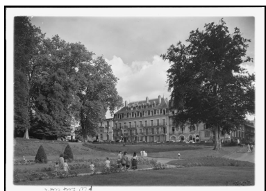
Façade nord, vue depuis le parc thermal au-delà de la rue des Thermes. Phot. Jules Manias IVR43_20067000916PY
