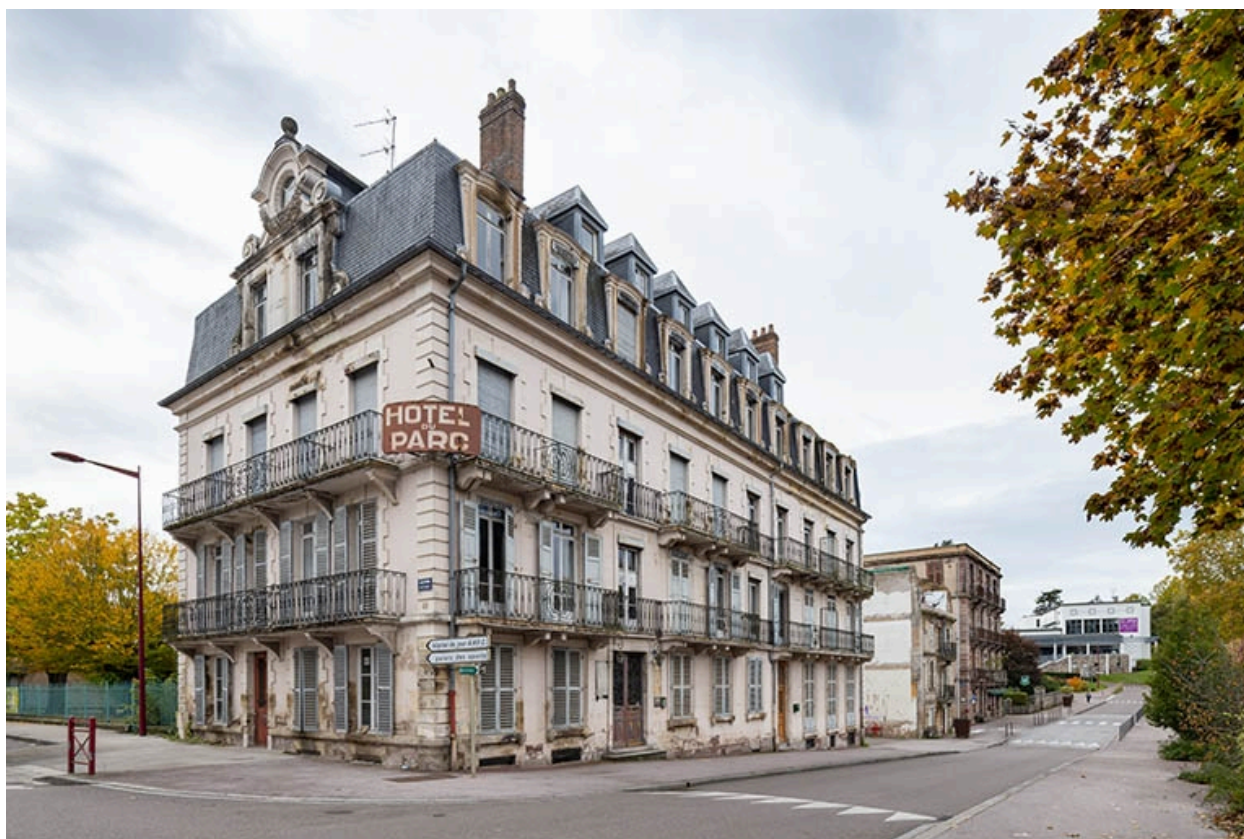
Façade nord et façade est, vue depuis l'angle du boulevard Richet (à gauche) et de la rue des Thermes (à droite).
