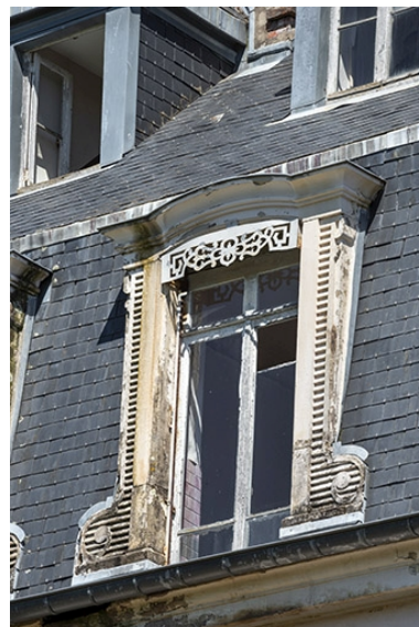
Façade sud, lucarne. Phot. Jérôme Mongreville IVR43_20207000583NUC4A
