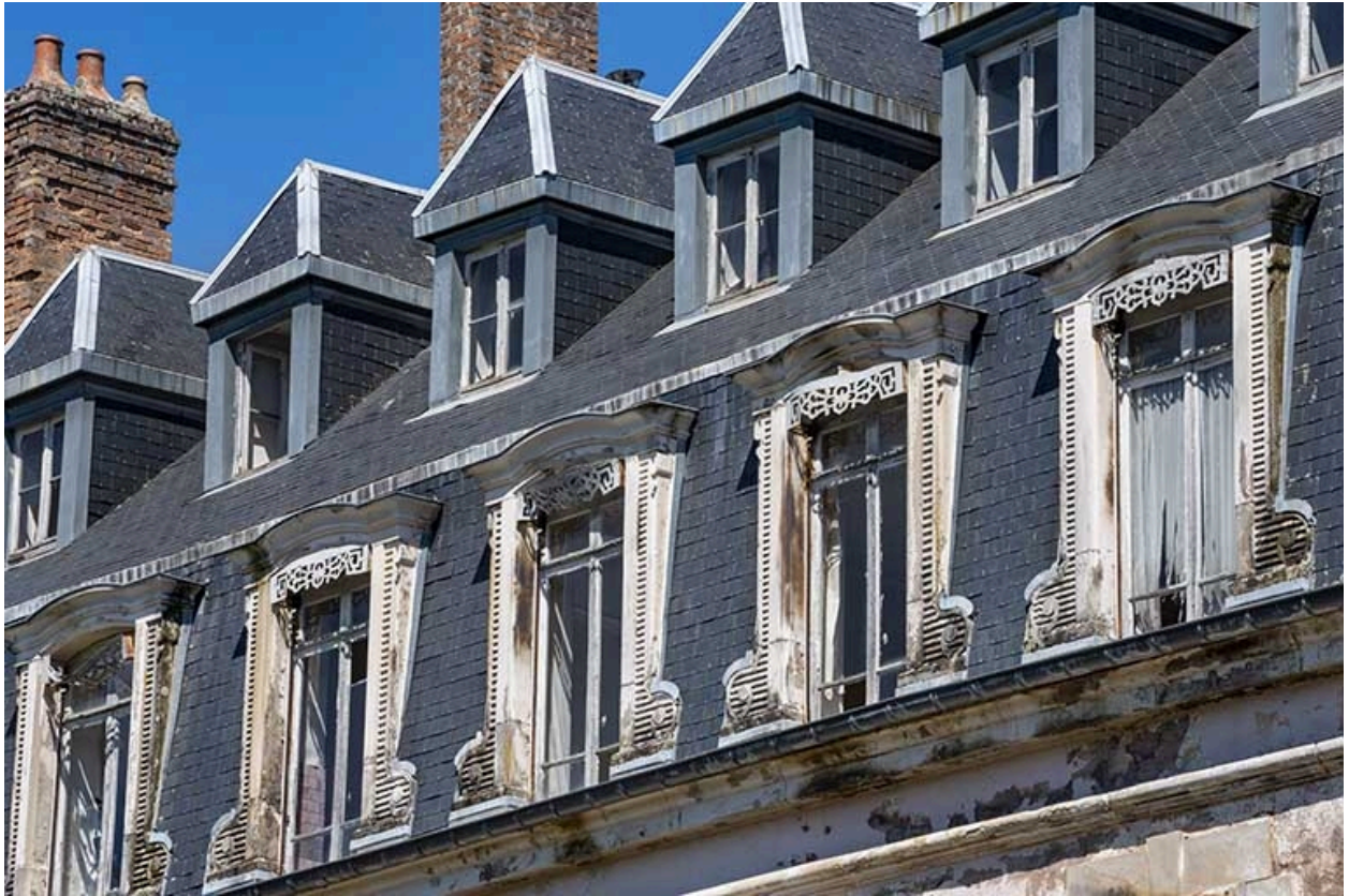
Façade sud, lucarnes.
