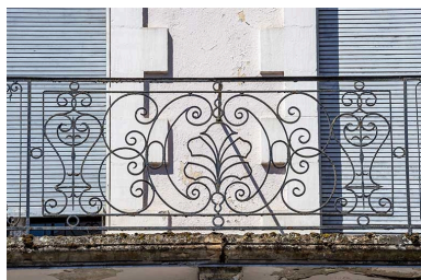
Façade est, garde-corps de balcon en fer forgé. Phot. Jérôme Mongreville IVR43_20207000579NUC4A
