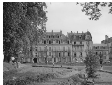
Façade nord, vue depuis le parc thermal au-delà de la rue des Thermes. Phot. Jules Manias IVR43_20067000937P
