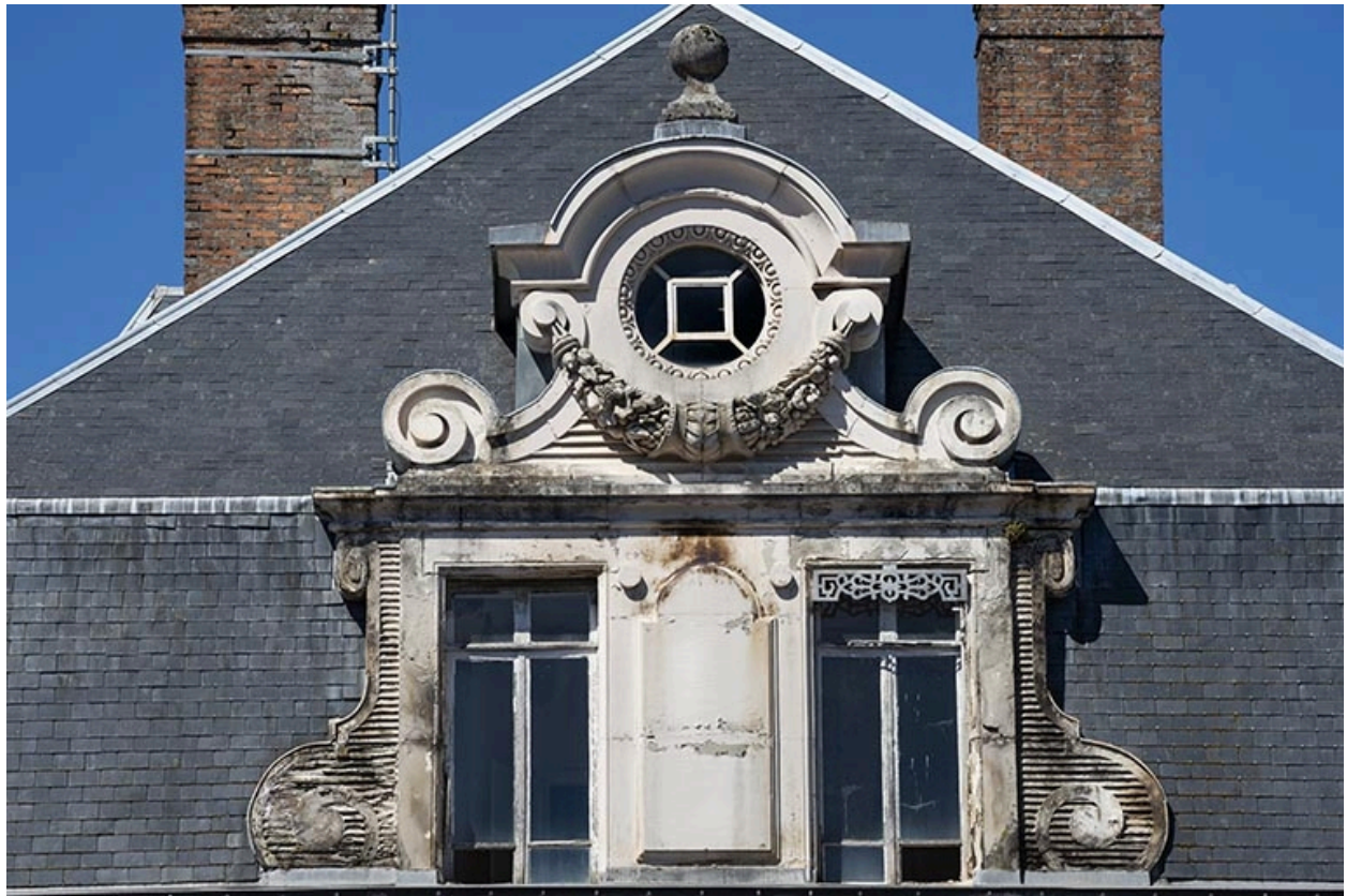
Façade est, détail de la grande lucarne, vue de face.
