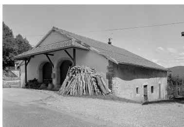
Façade postérieure et face sud. Phot. Jérôme Mongreville IVR43_19963901102X
