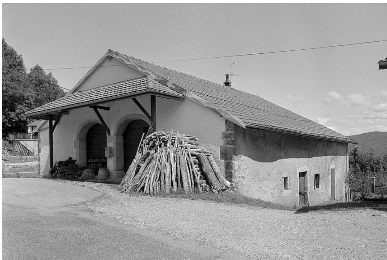
Façade postérieure et face sud.
