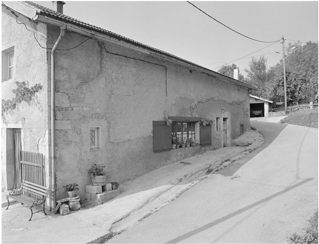
Atelier installé dans une partie de l'étable.
