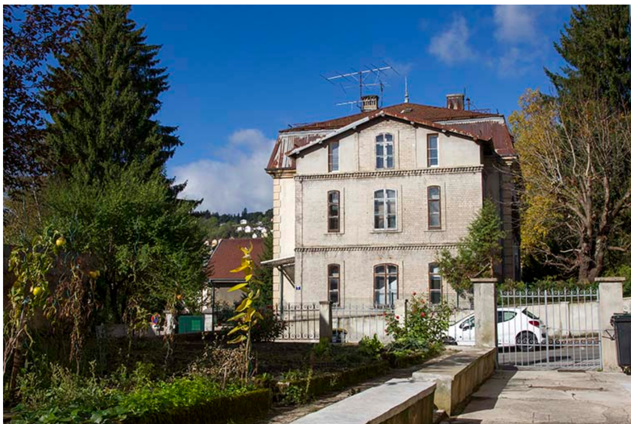
Logement patronal, vu de l'est.
