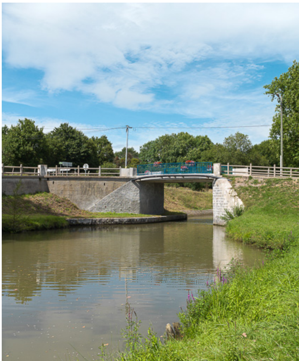
Vue d'ensemble du pont.
