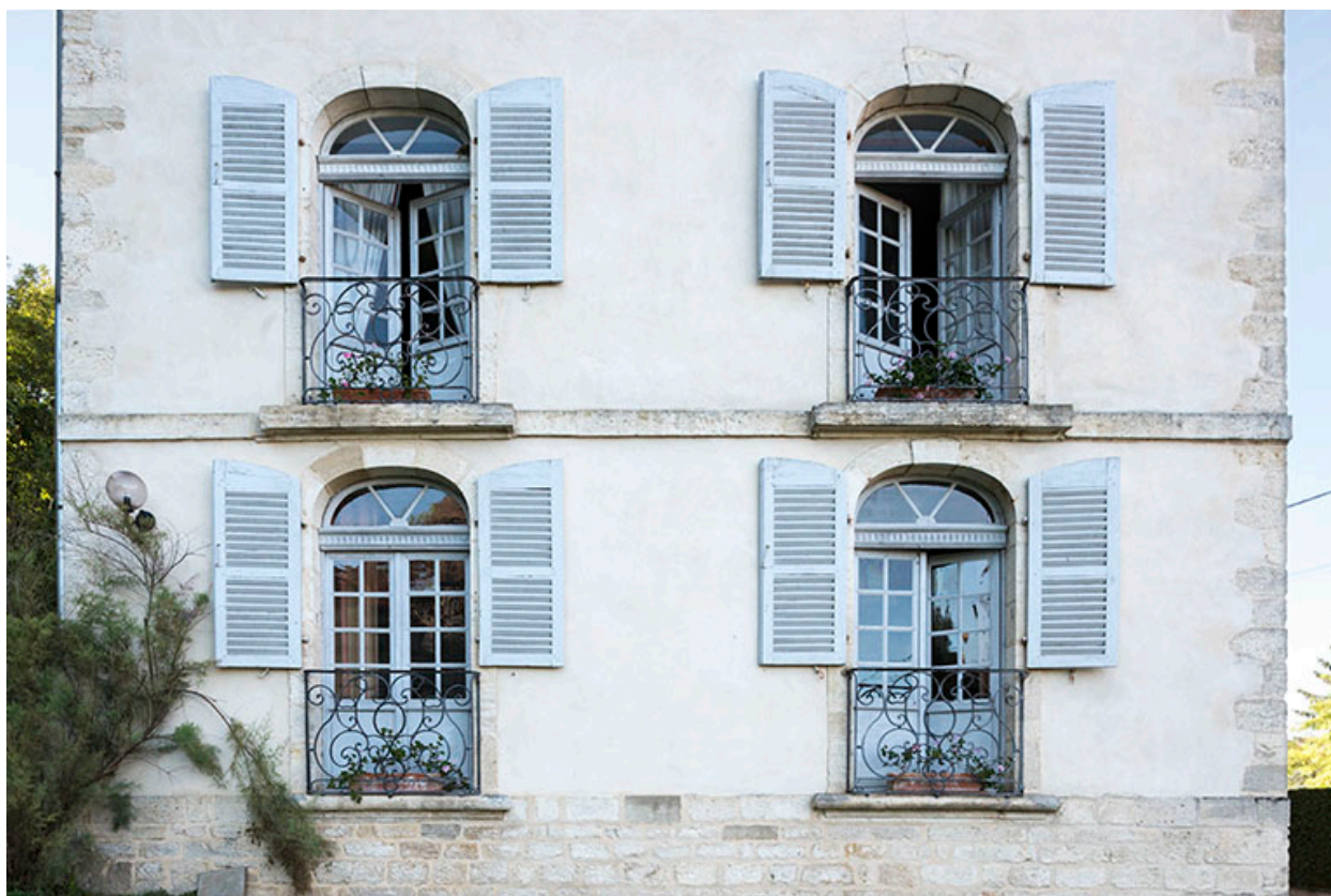
Ensemble des baies de la façade latérale droite.
