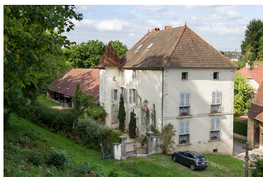
Vue générale de trois quarts de la façade antérieure, avec la tourelle et l'ancien "grangeage". Phot. Sonia Dourlot IVR43_20167000722NUC4A
