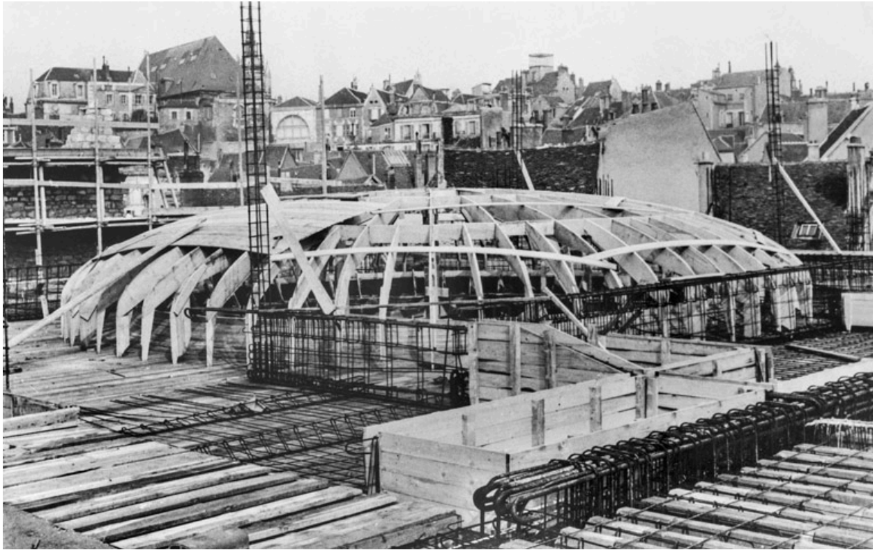
1er tableau : [2C] La coupole en construction, 1938.
