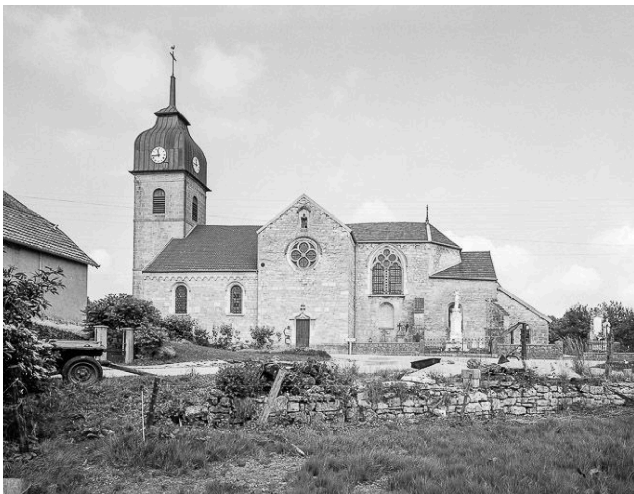
Façade latérale droite.
