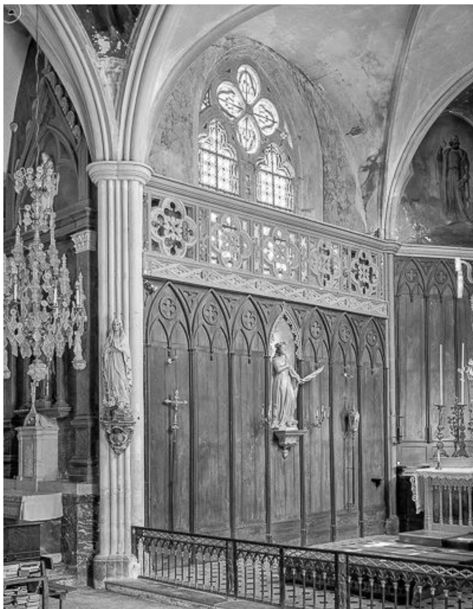
Intérieur : élévation gauche du chœur.
