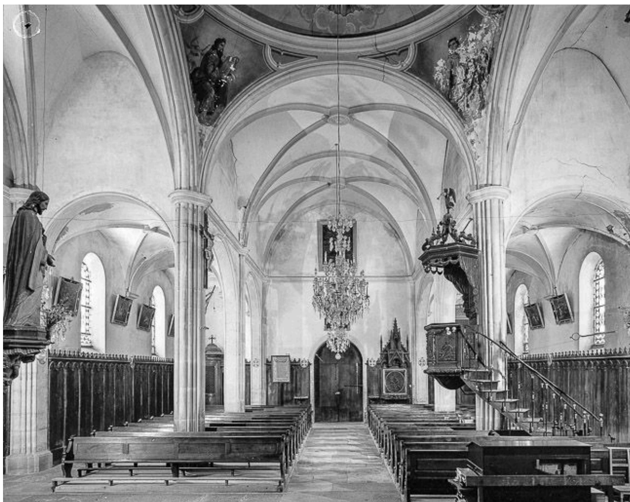
Intérieur : la nef vue depuis le chœur.
