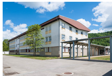
Internat : façade postérieure. Phot. Jérôme Mongreville IVR43_20143900504NUC4A
