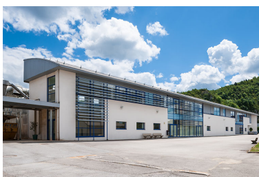
Ateliers, façade antérieure. Phot. Jérôme Mongreville IVR43_20143900484NUC4A
