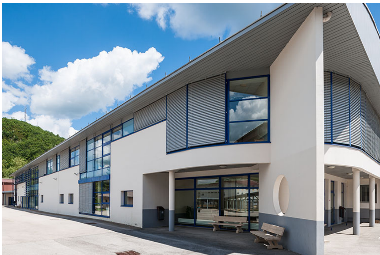
Ateliers : détail des façades et entrée.
