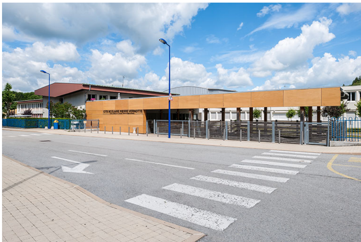
Entrée du lycée.
