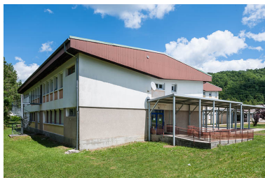
Externat : pignon sud. Phot. Jérôme Mongreville IVR43_20143900505NUC4A
