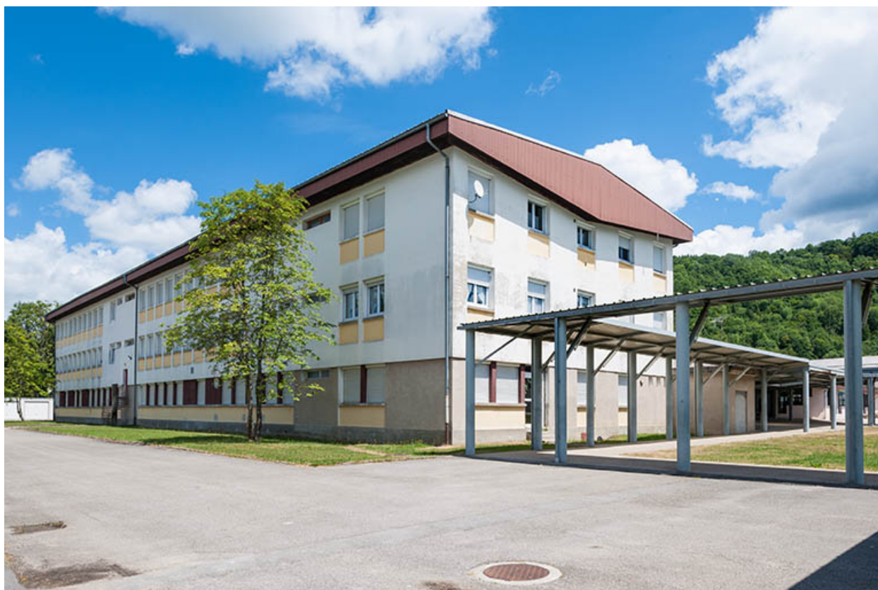
Internat : façade postérieure.
