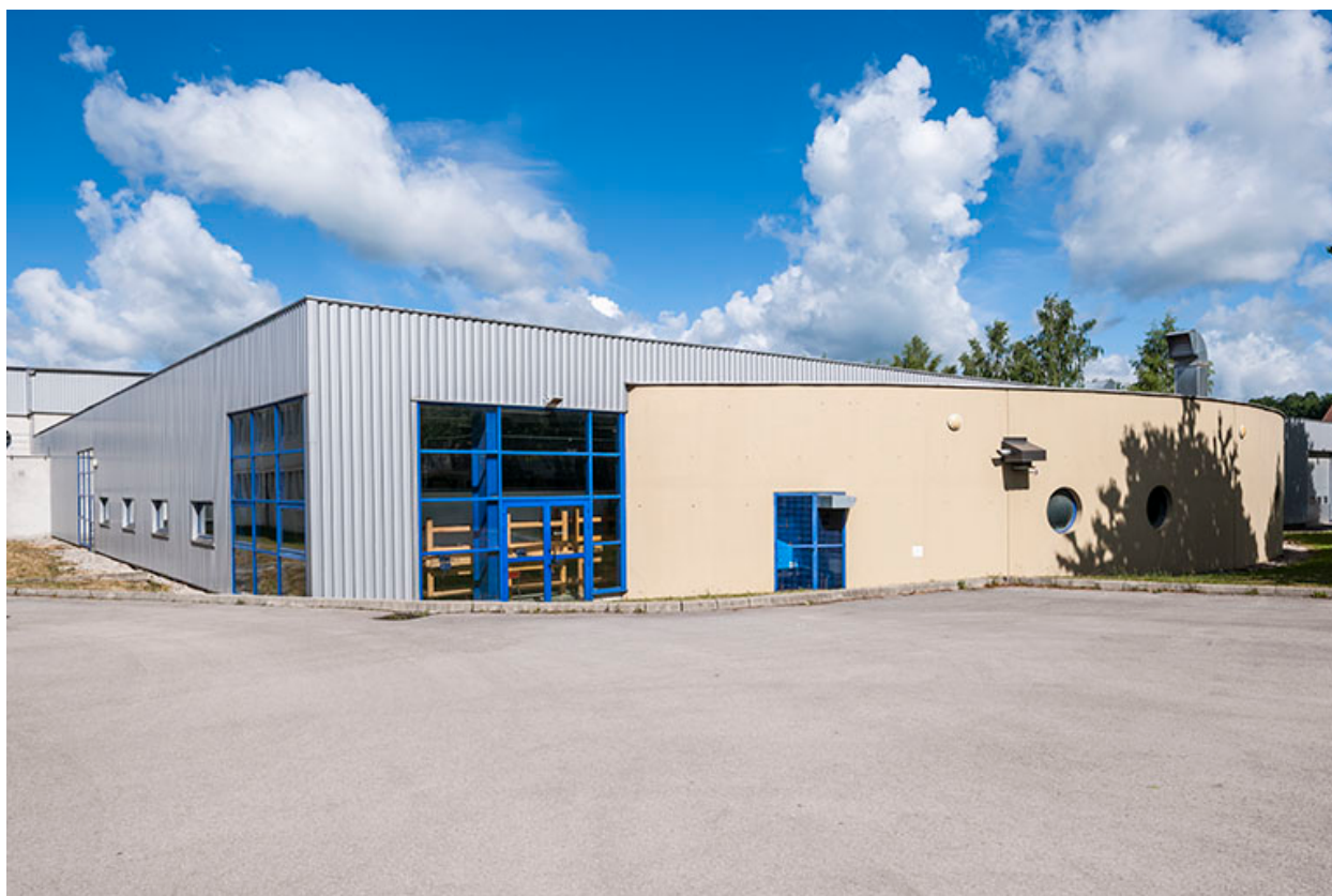
Ateliers, façade postérieure avec extension.
