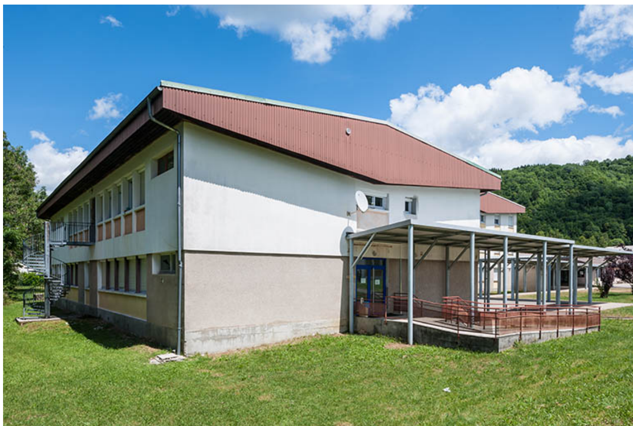
Externat : pignon sud.
