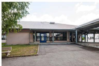
Restauration, façade Ouest, entrée. Phot. Jérôme Mongreville IVR43_20143900508NUC4A
