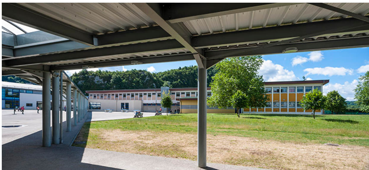
Restauration : passage et préau .
