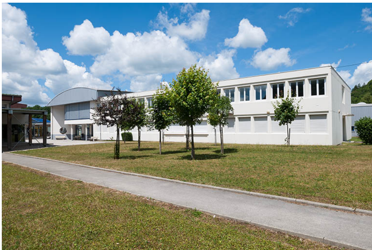
Ateliers, façade Sud.
