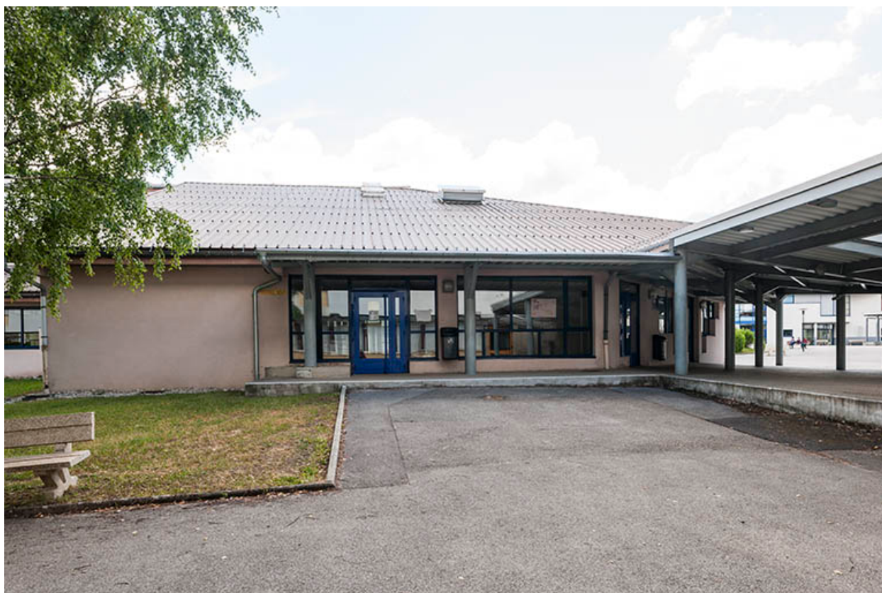
Restauration, façade Ouest, entrée.
