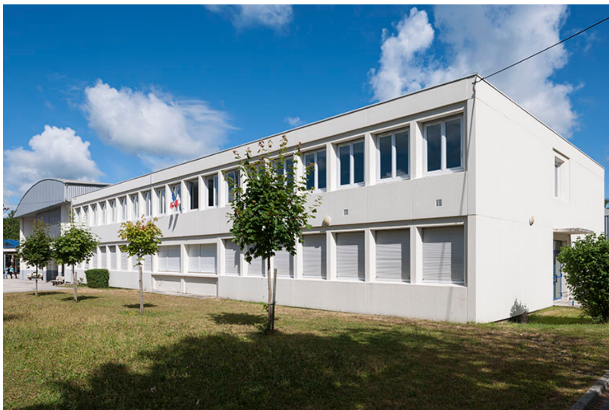
Ateliers, façade latérale Sud.
