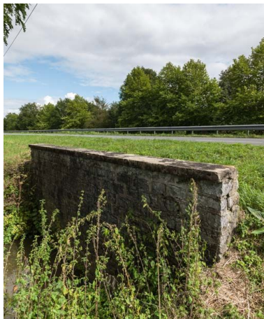
Vue de l'aqueduc.
