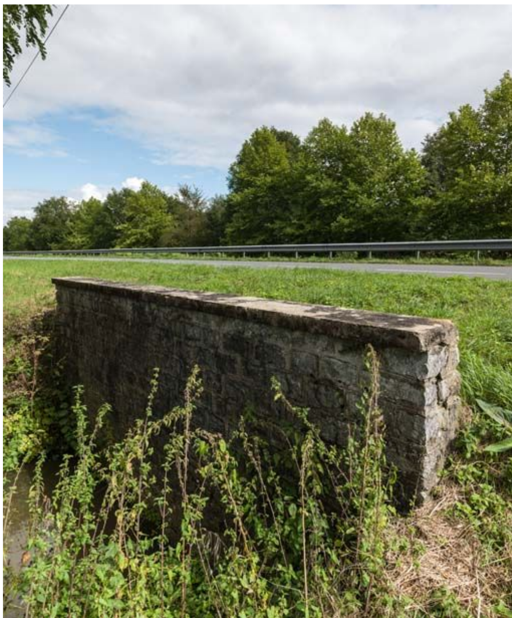
Vue de l'aqueduc.
