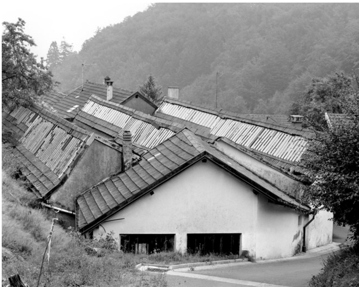
Sheds de l'atelier de fabrication depuis l'ouest.
