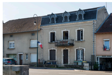
Maison n°6, vue de trois-quarts gauche. Phot. Jérôme Mongreville IVR43_20187000356NUC4A
