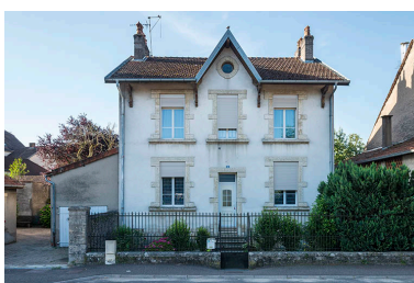
Maison n°10, vue de face. Phot. Jérôme Mongreville IVR43_20187000359NUC4A
