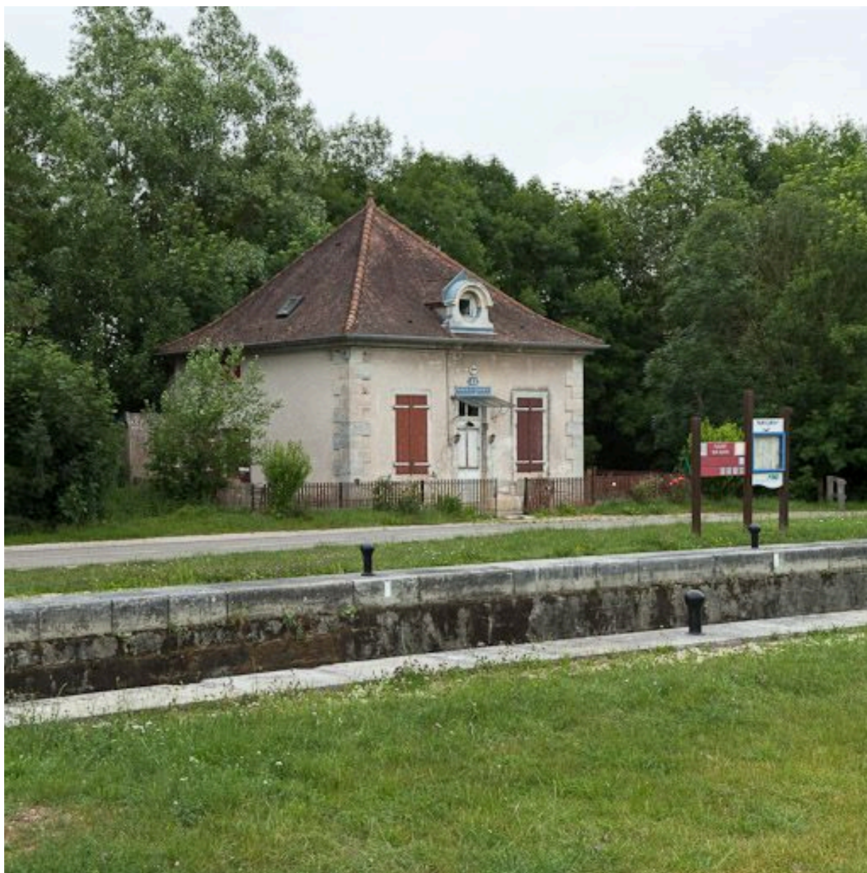
Vue du site d'écluse.
