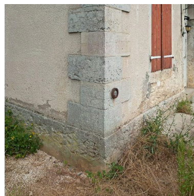
Détail des matériaux de la maison éclusière : chaîne d'angle et soubassement. Phot. Pierre-Marie Barbe-Richaud IVR26_20112103560NUC2AQ
