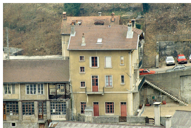
Vue d'ensemble depuis l'ouest. Phot. Laurent Poupard IVR43_19923901477ZA
