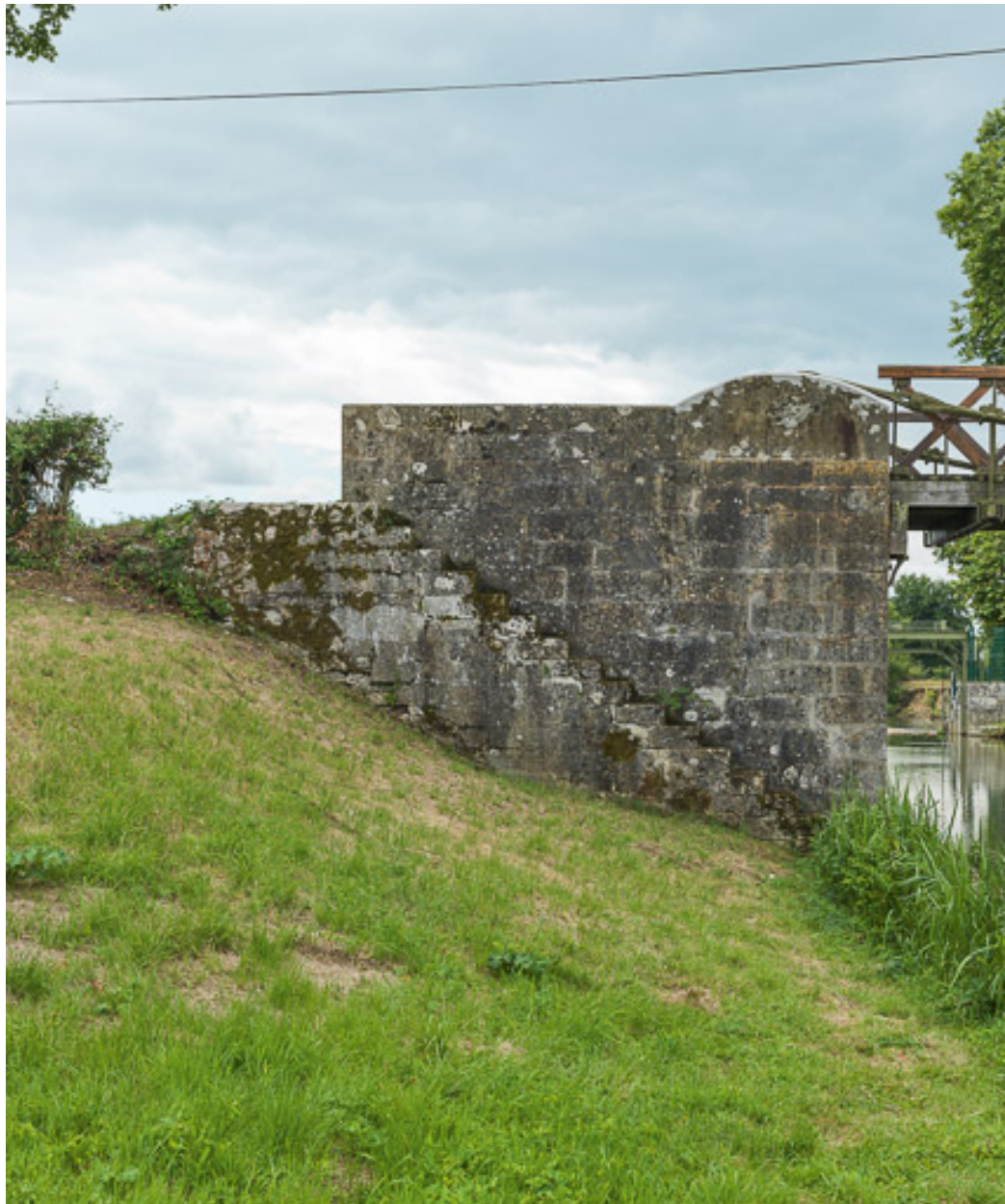
Détail d'une culée en moellons.
