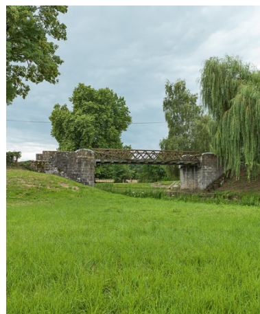
Vue de la passerelle.
