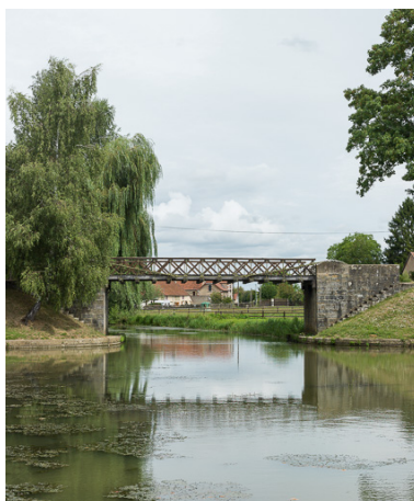
Vue d'ensemble de la passerelle.
