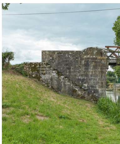
Détail d'une culée en moellons.
