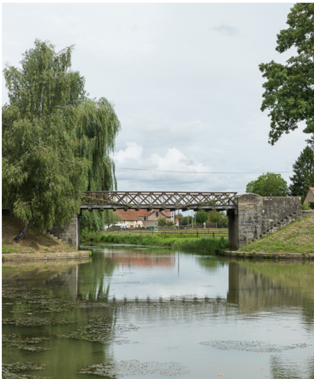
Vue d'ensemble de la passerelle.
