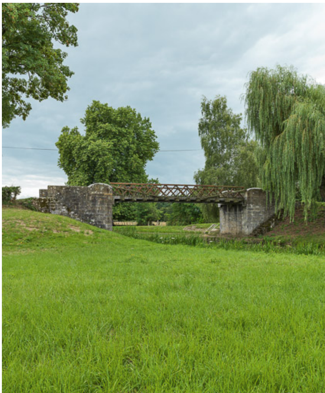
Vue de la passerelle.
