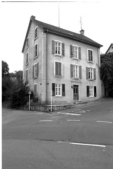
maison, 1 rue de Montbouton. Phot. Bernard Lardière IVR43_19829000152Z
