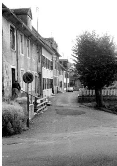
Alignement de maisons, rue du Clocher Phot. Bernard Lardière IVR43_19829000131Z
