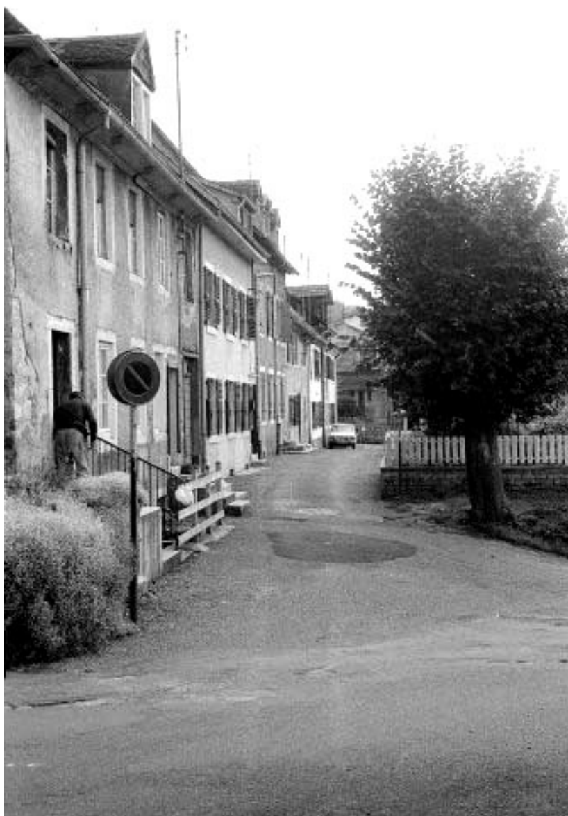
Alignement de maisons, rue du Clocher
